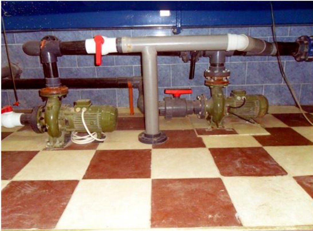
Figure 1.3 : Photographie montre le raccordement des pompes
