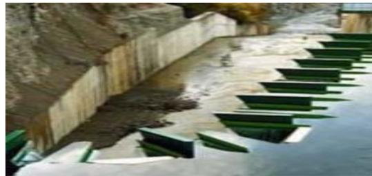
Figure II-03 : Hausse fusible (rôle du réservoir)
