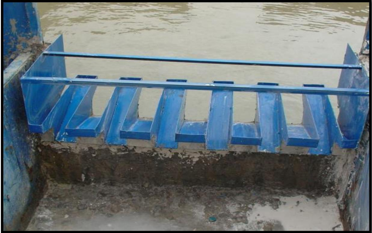
**Figure 05: Vue en plan du déversoir non rectiligne creusé**
