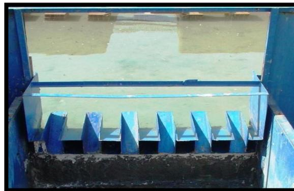
Figure V-31 : Forme en plan rectangulaire
