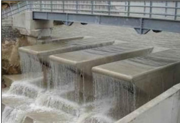
**Figure III-01 : Déversoir en labyrinthe développé réalisé en 2010 au barrage de Gloriettes, dans les Pyrénées – France**
