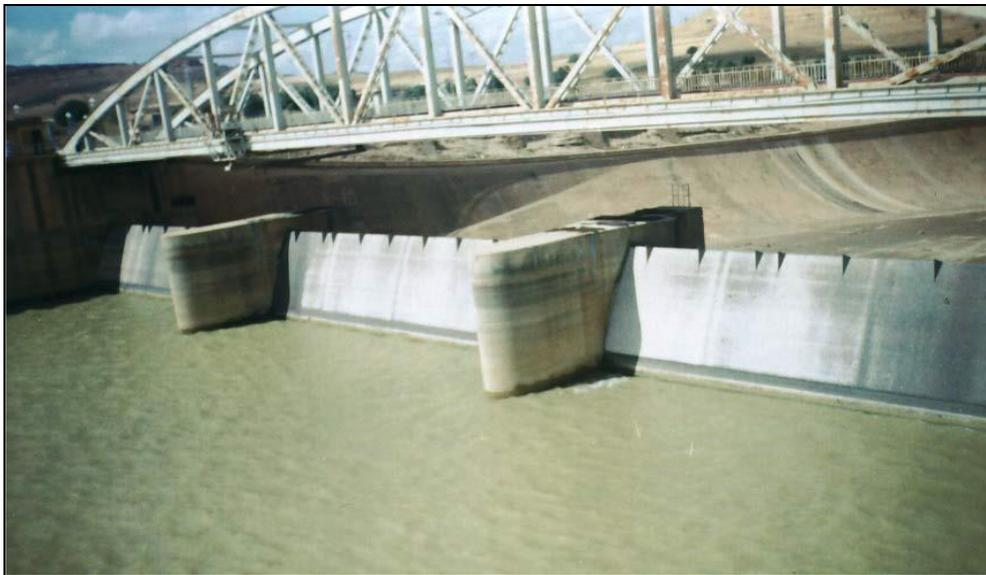
Figure I-02 : Évacuateur de crues – Barrage Bou-Hanifia – Algérie (A.N.B.T)
