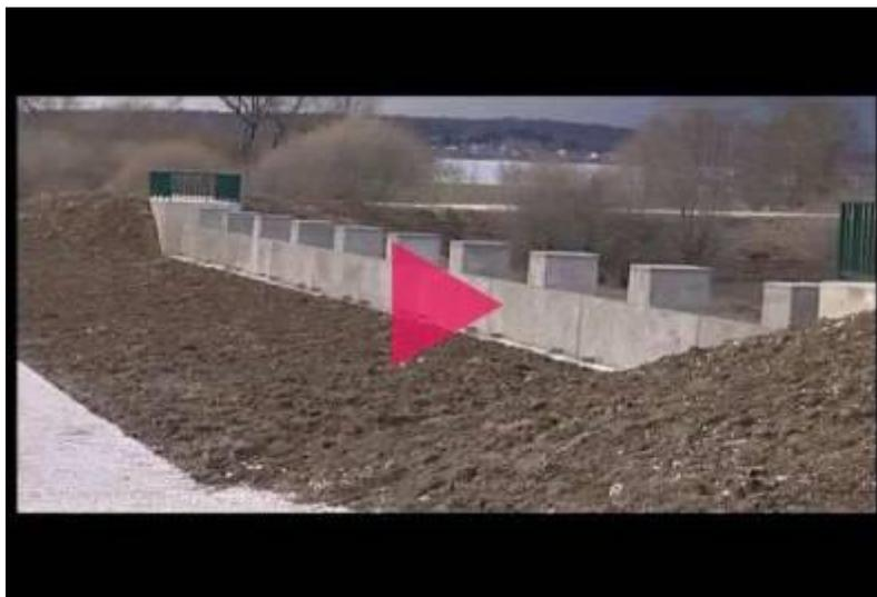
**Figure II-14 : Déversoir (digue fusible) - France**
