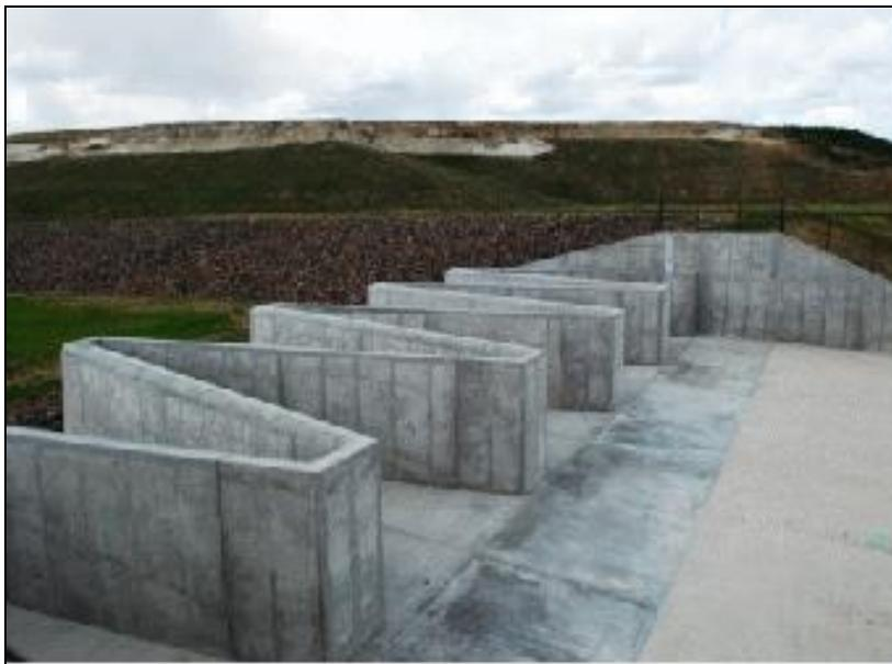
**Figure I-22: Vue en plan du déversoir en labyrinthe traditionnel (I.C.O.L.D)**
