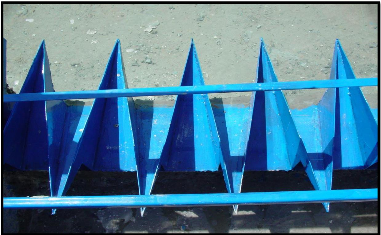
**Figure 08: Forme en plan du déversoir en labyrinthe développé triangulaire**
