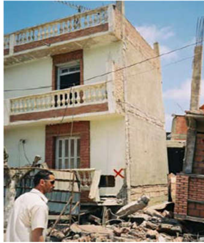
Figure 1-14 : Effondrement d'un bâtiment d'habitation individuel à cause de la défaillance des poteaux de l'étage souple, Boumerdès 2003
