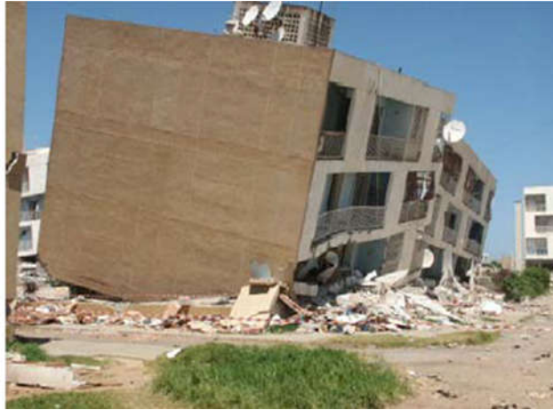
Figure 1.13 Effondrement complet d'une construction au niveau 1 Boumerdès 2003
