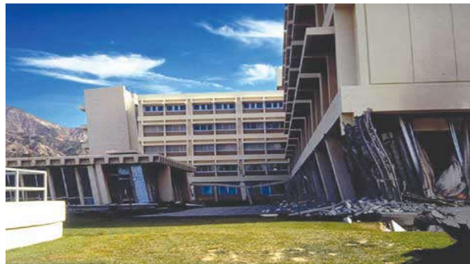
Figure 1.9 : hôpital Olive après le séisme de San Fernando, dommages typiques dus à la discontinuité du mur
