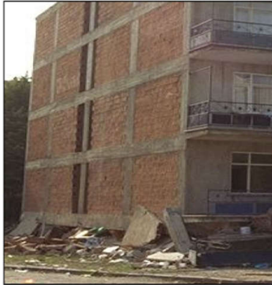
Figure 1.12 Effondrement à cause de la distribution irrégulière des murs de remplissage, Izmit 1999
