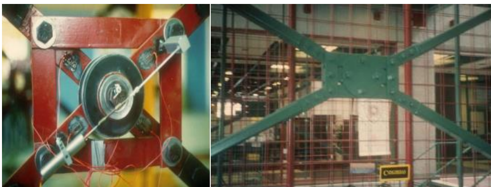
Figure 3.3 Dispositif d'amortissement de friction
