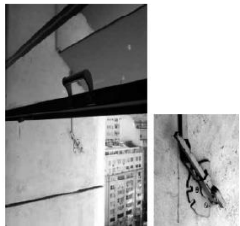
Figure II.2: Brise-soleil avec des lames horizontales mobiles pour bloquer les radiations solaires indésirables.(Souce : J. Manuel Melendo,2008)
