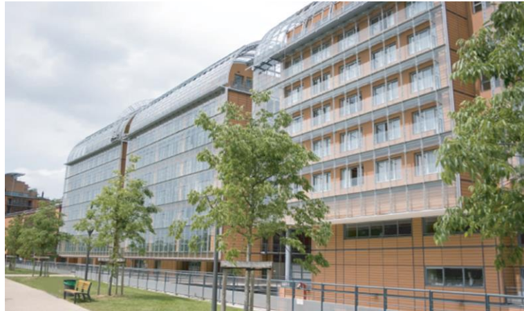
Figure IV.25: Façade double vitrage ,Cité Internationale de Lyon). (Source: http://www.somfyarchitecture.fr )
