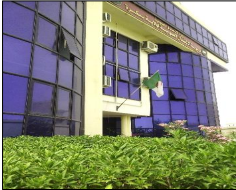
Figure V.21: Bâtiment de la DTP a Biskra, entrée principale, façade Sud. (Source : Auteur)
