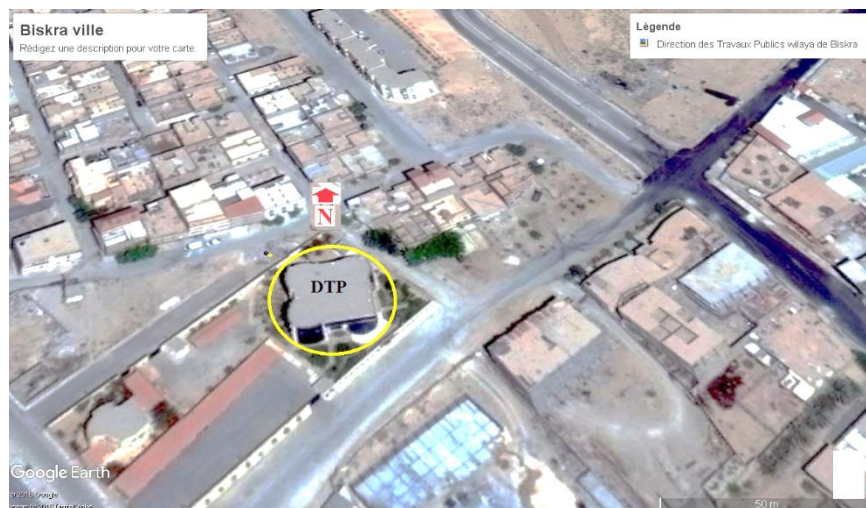
Figure V.15 : Vue aérienne du bâtiment de la direction des travaux publics (DTP)côtéSud. (Source : GoogleEarth)
