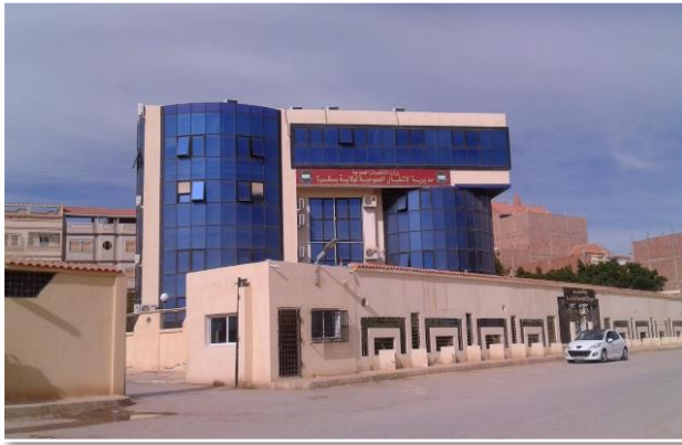
Figure V.18: Bâtiment de la DTP a Biskra, dans son contexte immédiat. (Source : Auteur)
