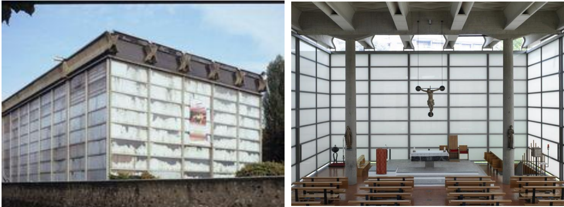
Figure I.13 : l'église de Baranzate près de Milan, Angelo Mangiarotti et Bruno Morassutti, vue de l'extérieur (à droite), l'effet de la lumière à l'intérieur (à gauche). Source : http://www.30giorni.it/articoli_id_77448_14.htm
