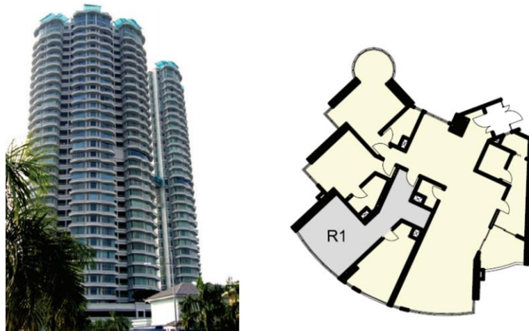
Figure IV.12 : Le bâtiment de Penang , vue extérieur à gauche , vue en plan à droite. (Source : Nidhal,2011)
