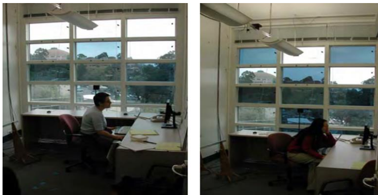
Figure IV.41 : Deux situations différentes de changement de la teinte du vitrage électrochromique selon les préférences des occupants. (Source : Lee et al,2006)
