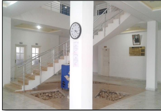
Figure V.22: Bâtiment de la DTP a Biskra, l'escalier principal. (Source : Auteur)
