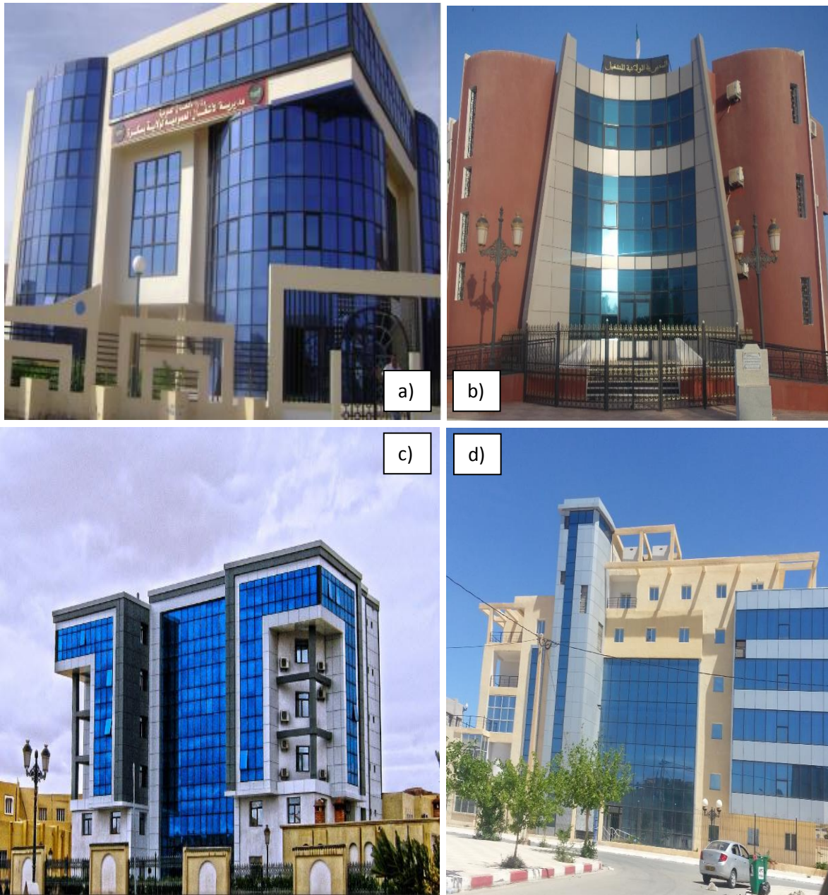
Figure V.5 : Exemples des bâtiments situés dans la zone III . Direction des travaux public, Biskra(a), direction d'emploi, Adrar(b),Rectorat, université de Laghouat(c),(d).direction d'emploi,M'sila (Source : Auteur)
