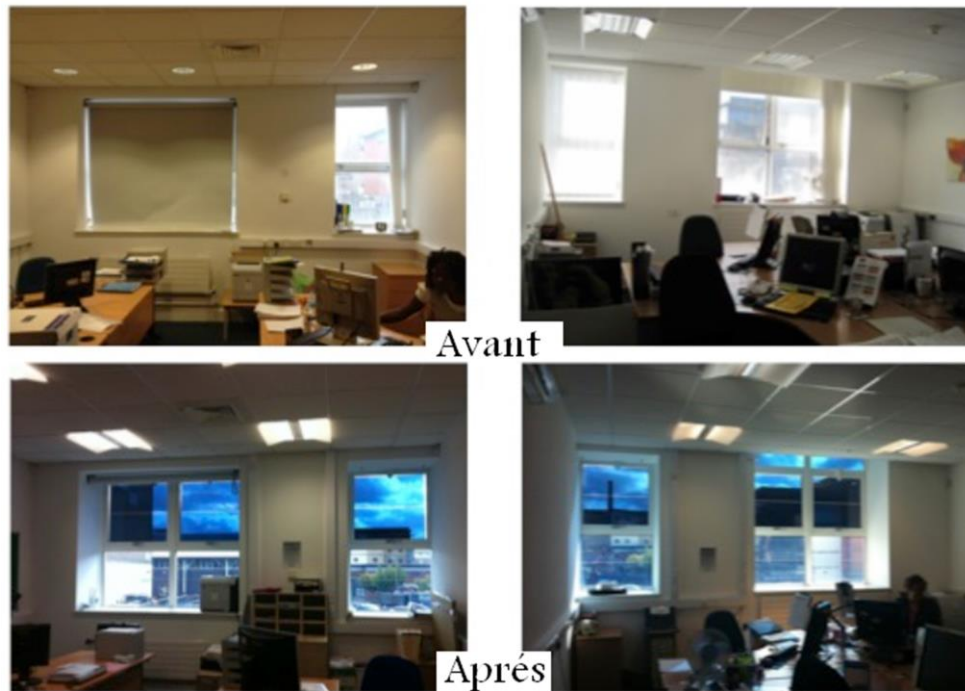
Figure IV.42 : Vues à l'intérieur des bureaux ,avant et après l'intégration du verre électrochromique sur les fenêtres . (Source : Kelly,2013)
