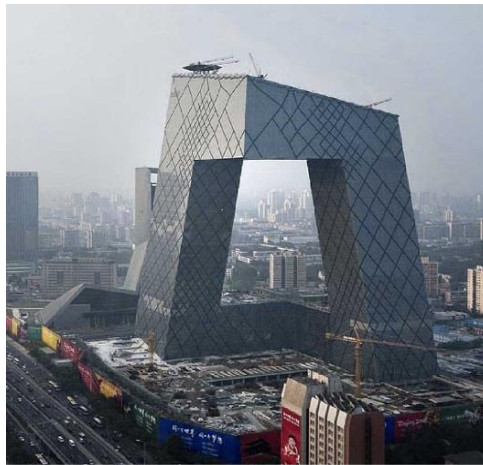
FigureI.32 : Quartier général de la télé centrale de la Chine,Pekin,East China Architectural Design, 2004. Source : http://arkfo.dk/da/blog/nutiden-er-sted%C3%B8s
