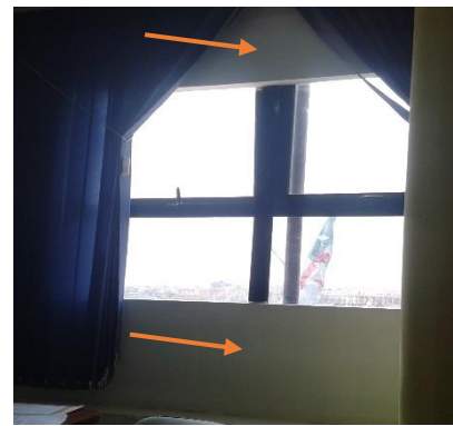
Figure V.28 : les plaques en plâtre réalisées sur le mur rideau d'un bureau de la DTP (Source : Auteur).
