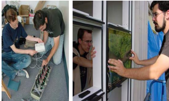
Figure IV.40: Installation du système de verre électrochromique . (source : Lee et al,2006)
