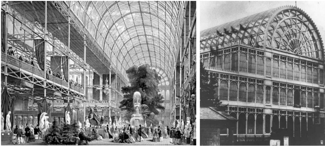
Figure I.5 : Crystal Palace, Londres, 1851. Vue de l'intérieur (à gauche), vue de l'extérieur (à droite). Source : Pinto, 2015
