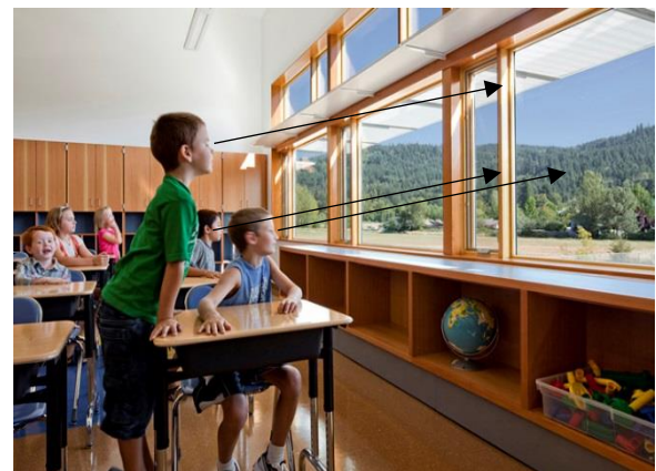
Figure IV.8 : Vue vers l'extérieur par une fenêtre équipée d'un Light-shelve . (Source : http://simplicable.com/new/light-shelves )
