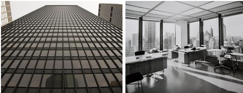
Figure I.14 : Le bâtiment Seagram, vue de la façade en verre fumé (à droite), vue sur la ville de New York depuis l'intérieur des bureaux (à gauche). Source : https://www.pinterest.fr/pin/584905070324726935/
