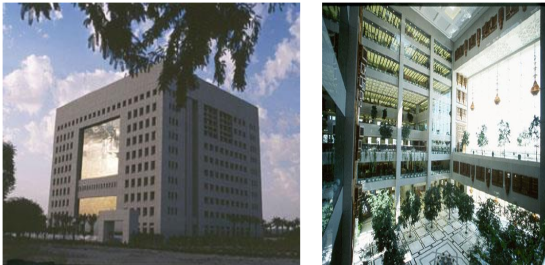
Figure II.12: Siège Social d'Organisation Arabe, Kuwait city, 1994.(a)vue de l'extérieur(b) vue sur l'atrium (Source : http://www.pace-kuwait.com/arabfund.html )
