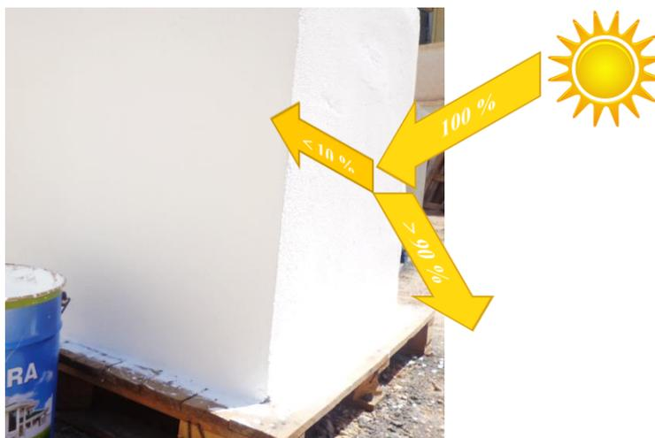
**Figure 6.10** : Principe du fonctionnement de la façade avec la peinture isolante exploitée
