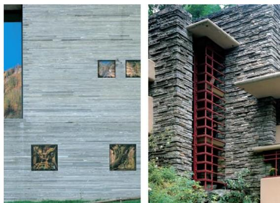
**Figure 2.36 :** Façade monocouche ou simple peau (Source : Herzog et al., 2004)
