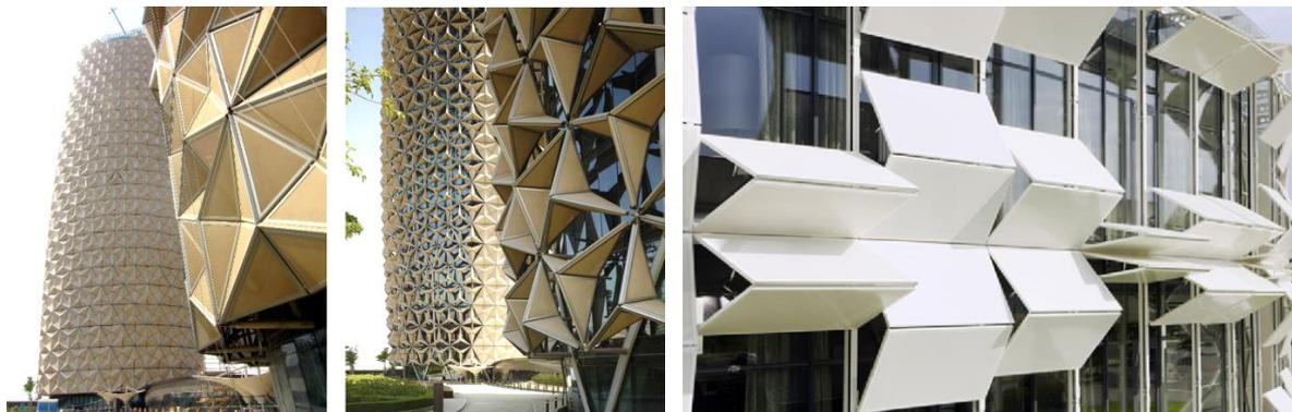
**Figure 4.36 :** Exemple des façades adaptatives des projets réalisés
