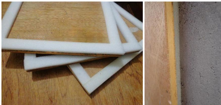
**Figure E.8 :** Le joint des ouvertures (Source : Auteur, 2017)
