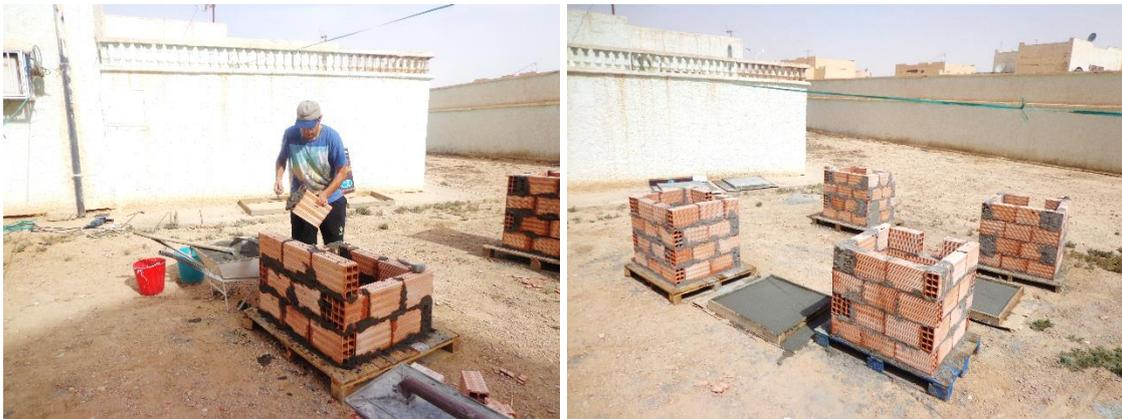
**Figure E.1** : Les étapes de la réalisation des cellules tests (Source : Auteur, 2017)
