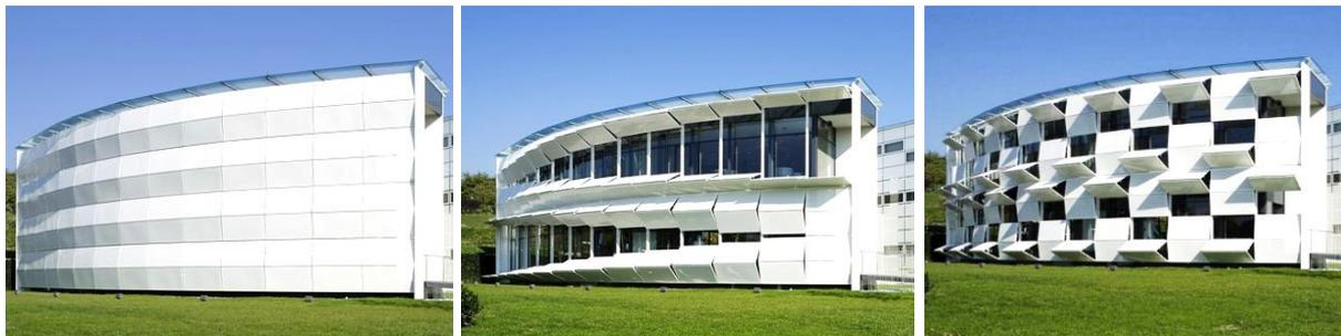
**Figure 2.9 :** Type d'une façade intelligente dynamique (Source : Menzel, 2012)
