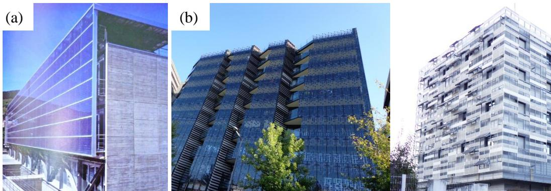
**Figure 2.54 :** Les façades photovoltaïques (Source : (a) Duran, 2011 ; (b) Auteur, 2017)
