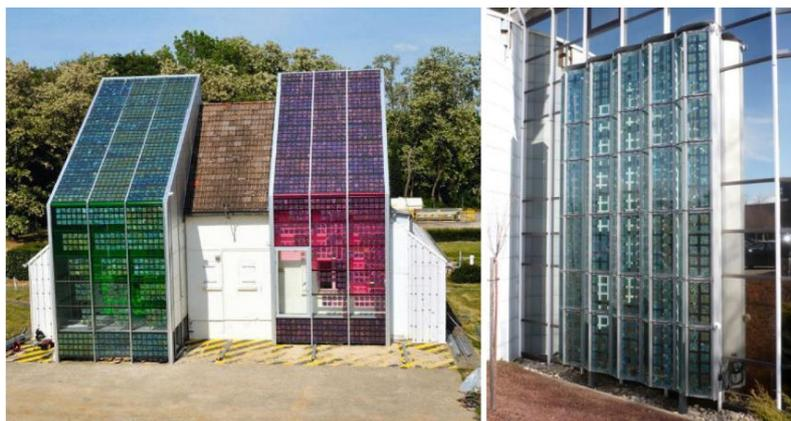
**Figure 4.31** : La façade double peau avec des capteurs photovoltaïques semi-transparents
