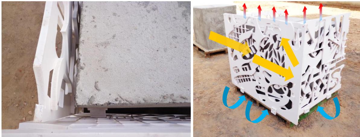
**Figure 6.14** : La cavité d'air de la cellule "C4" et le principe du fonctionnement de la façade double peau (Source : Auteur, 2017)
