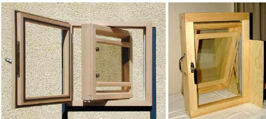
**Figure 4.12** : Deux types de fenêtres réversibles (Source : Erell et al., 2004)
