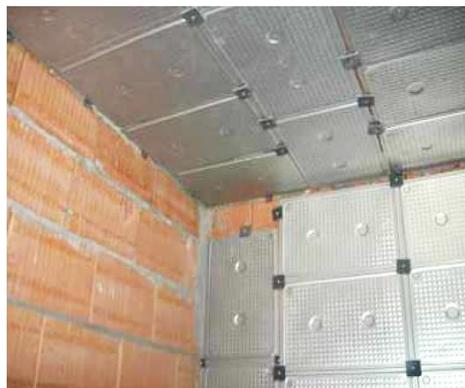
**Figure 2.32** : Exemple de l'intégration des matériaux à changement de phase dans les parois (Source : Guichard, 2013)
