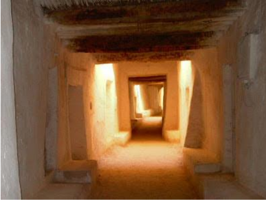
الشكل 1. 15. صورة لأحد شوارع واحة غدامس الليبية. وتبين الصورة أن الشارع به أجزاء مشمسة وأجزاء مظلمة مما يؤدي إلى حدوث نسيم مفتعل في فصل الصيف وهو ما يعرف بنظام الأروقة النصف مغطاة. المصدر: اللافي (2012).
