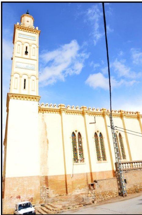
Figure 70 : les ouvertures de la façade droite
