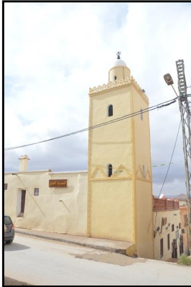
Figure54:vue d'angle de la mosquée Atik .source (auteur)
