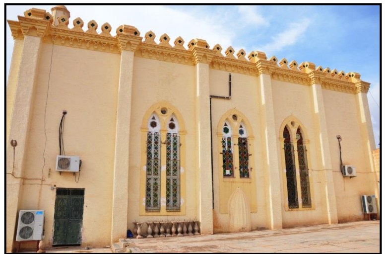
Figure 71: les ouvertures de mur de la qibla
