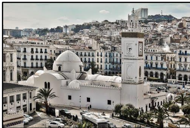
Figure13 : vue sur la grande Mosquée Alger-djamaa el-kebir(www.panoramio.com )
