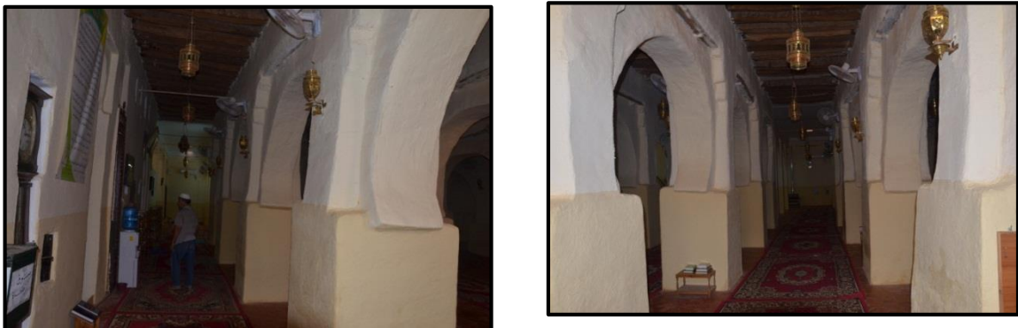
Figure 84,85: vues d'intérieur sur la mosquée Attik source : (auteur)
