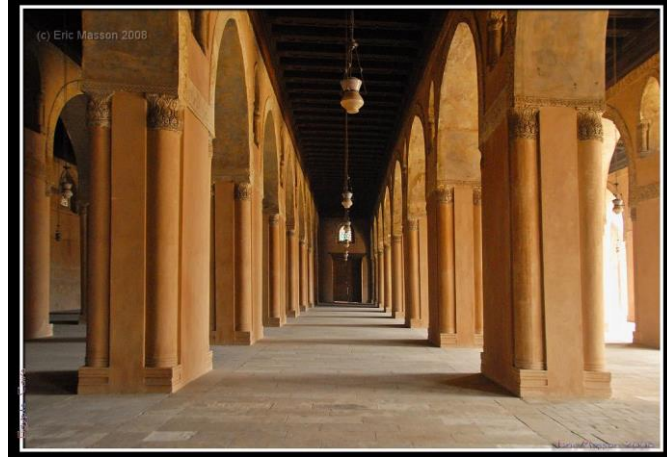
Figure34: Vue intérieure sur les portiques de la mosquée Ibn Toulon (ericmasson.be)
