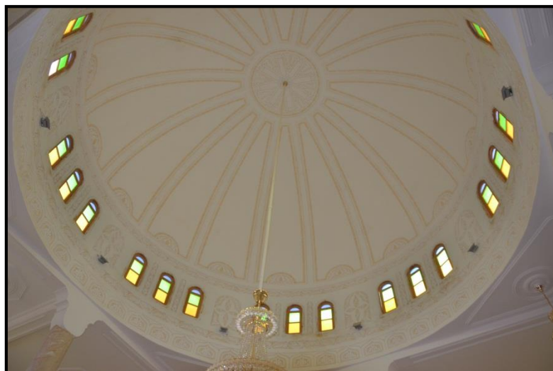
Figure 83: vue d'intérieur sur les ouvertures de la base de la coupole source : (auteur)
