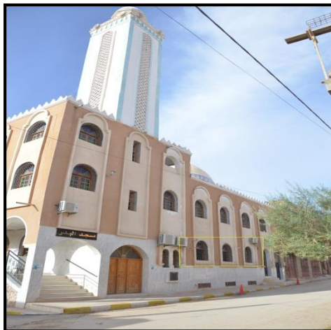
Figure81:vue d'extérieur sur la façade De mur de qibla. Source (Auteur)
