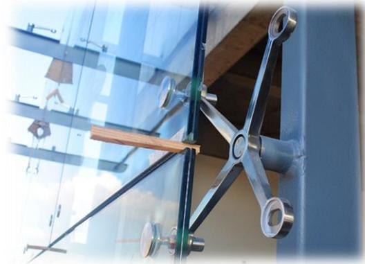
Figure 40 : Verre attache par des boulons traversant. (Source : pinterest.com).
