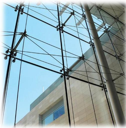
Figure 41 : Paroi en verre supporte par une structure en câble inoxydable. (Source : glasscon.com).
