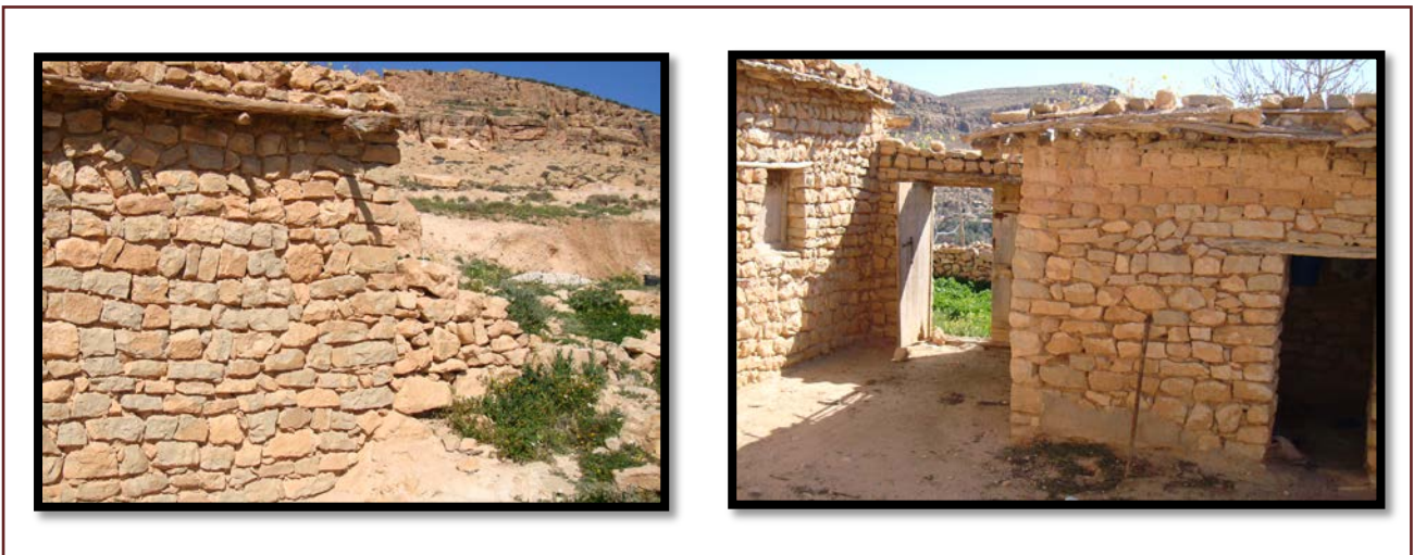
Fig n° (35) : des habitations dans Tizi de Beni Fareh dans la direction perpendiculaire à la pente.
