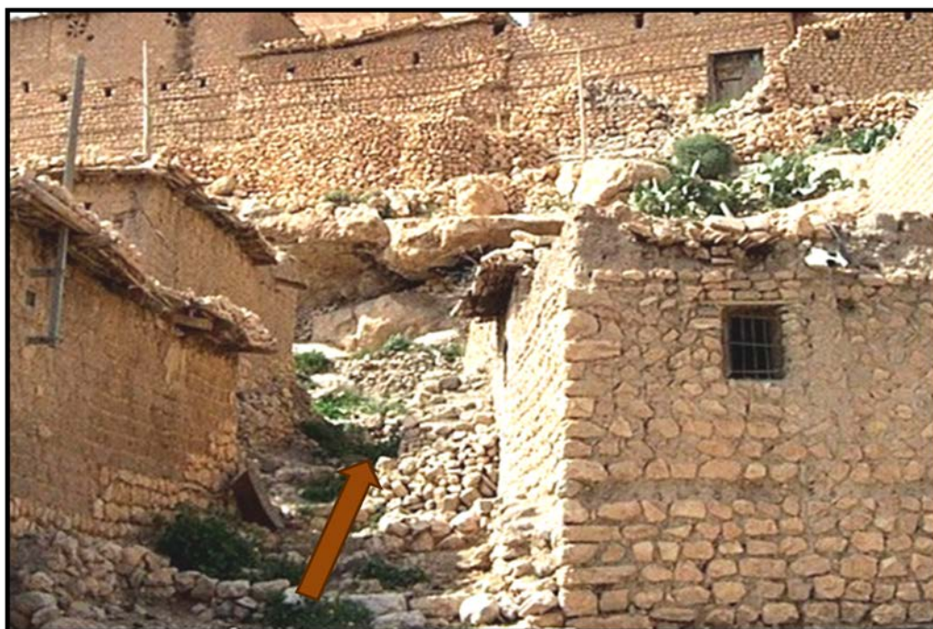
Fig n° (19) : les voies piétonnes en forme d'escaliers au niveau de Loussata.
