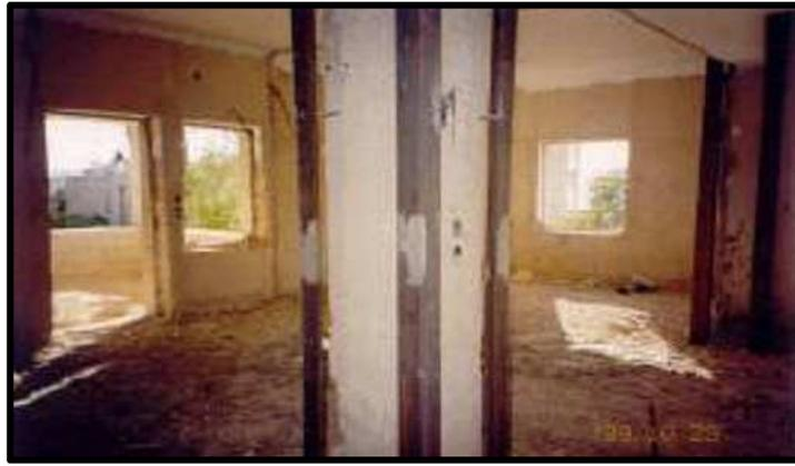
**Figure III.7:** Renforcement De Poteaux Au Moyen De Profiles Métallique. [21]
