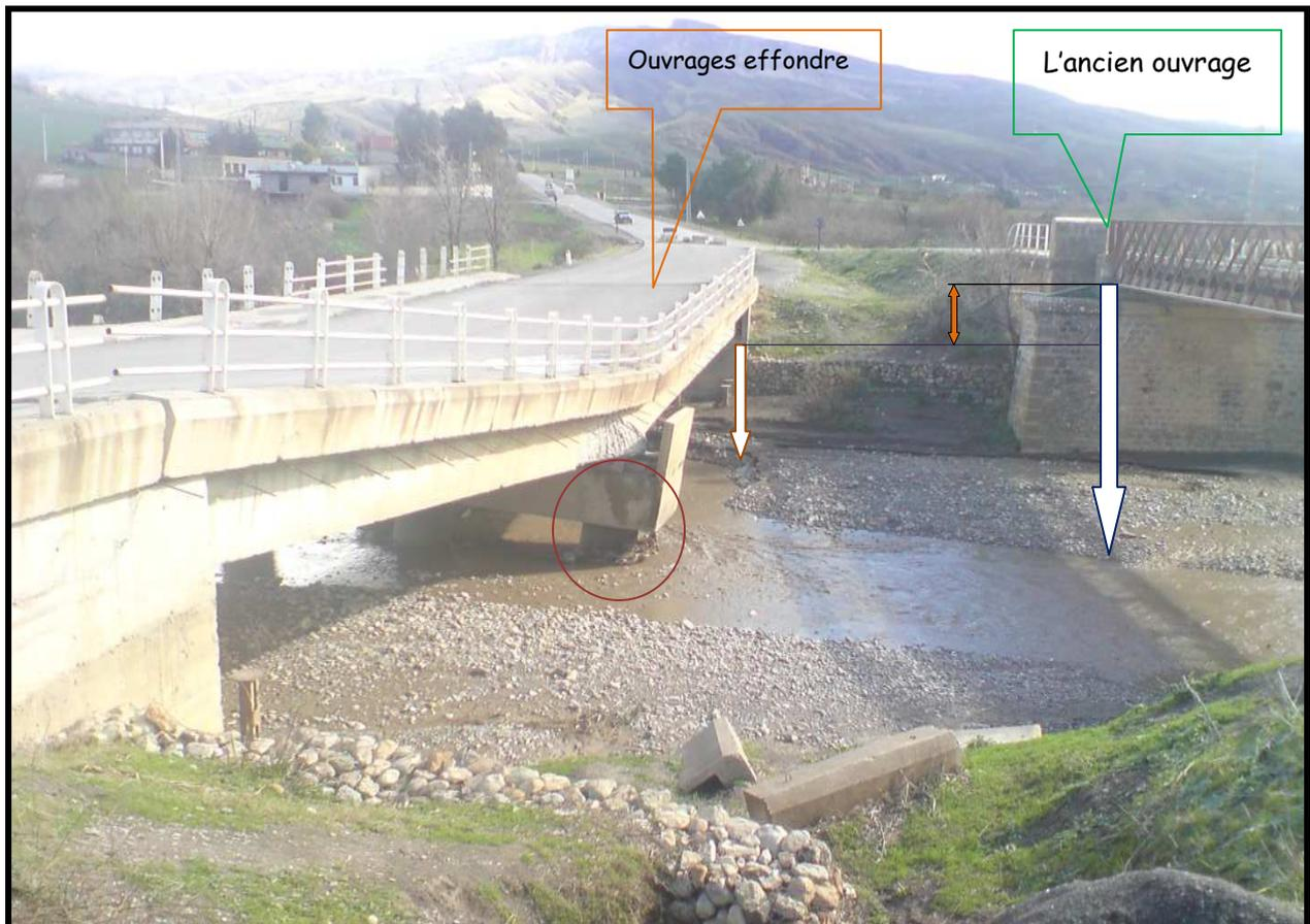
**Figure IV.23 :** Illustration de l'ancien ouvrage et les dégradations de notre ouvrage
