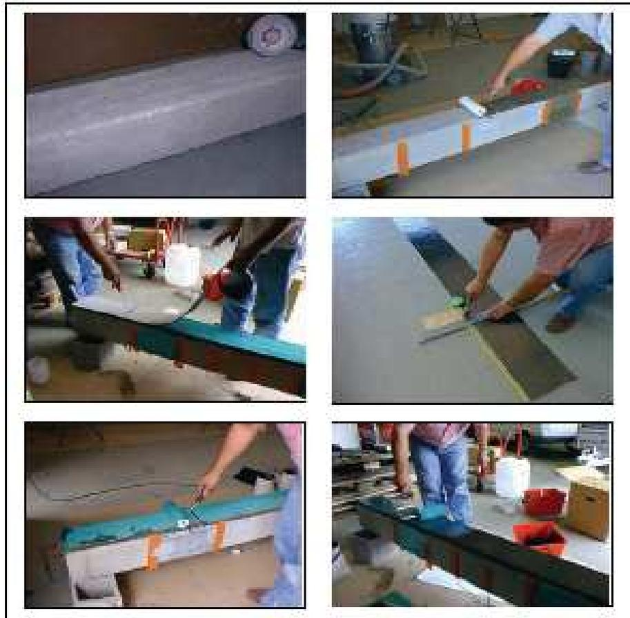
**Figure III.5:** Mise En Œuvre Par Stratification Directe.
