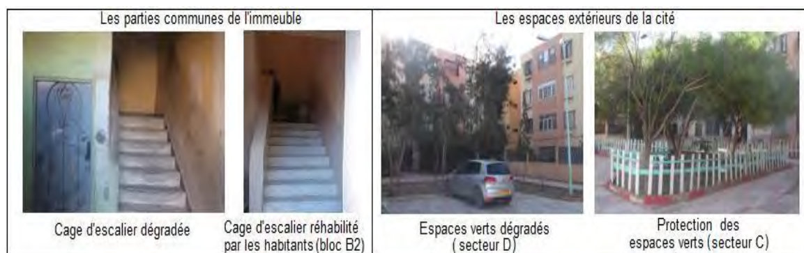
Photos X.1 : Les travaux de réhabilitation initiés par les voisins.
