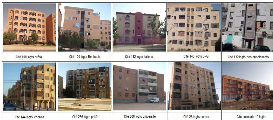
Fig. 0.2 : Situations dégradées des cités de logements sociaux collectifs transformés en copropriétés dans la ville de M'sila Source : Auteur, clichés 2015.
