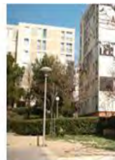
Photo II.8 : Façades après réhabilitation
