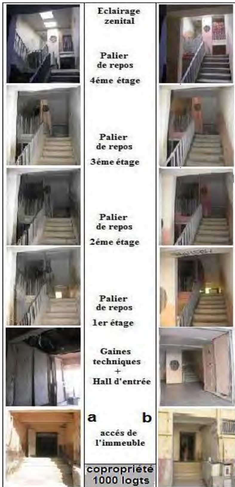
Photos XI.5 : Comparaison entre deux cages d'escaliers, copropriété 1000 logements. Source : Auteur, clichés 2016.
