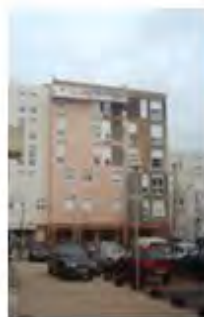
Photo II.7 : Travaux en cours
