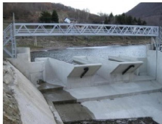
Figure I.71. Déversoir en touches de piano réalisé en 2006 au Barrage de Goulours-France ([www.pk-weirs.ulg.ac.be](http://www.pk-weirs.ulg.ac.be)).
