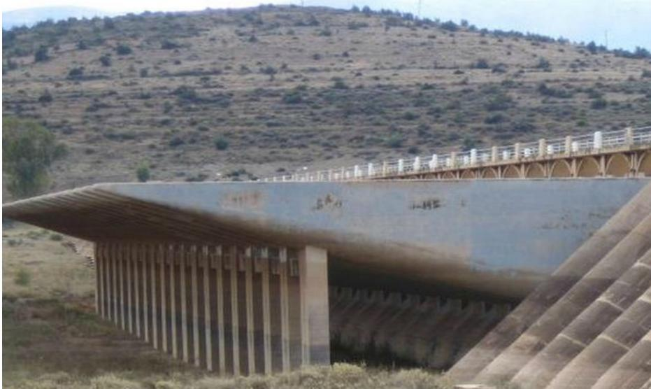
*Figure I.31. Déversoir en labyrinthe réalisé en 1944 au Barrage de Beni Bahdel (Algérie) ([www.anbt-dz.com](http://www.anbt-dz.com)).*
