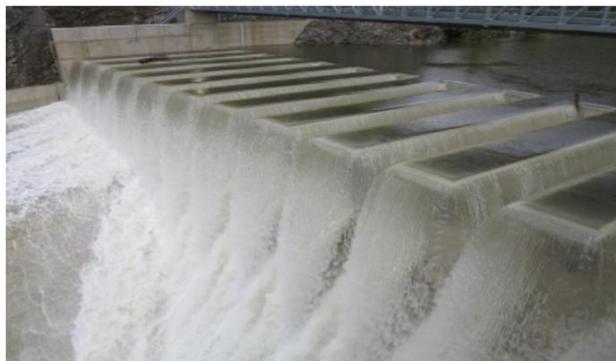
Figure II.01. Déversoir en touches de piano - Barrage Malarce – France
