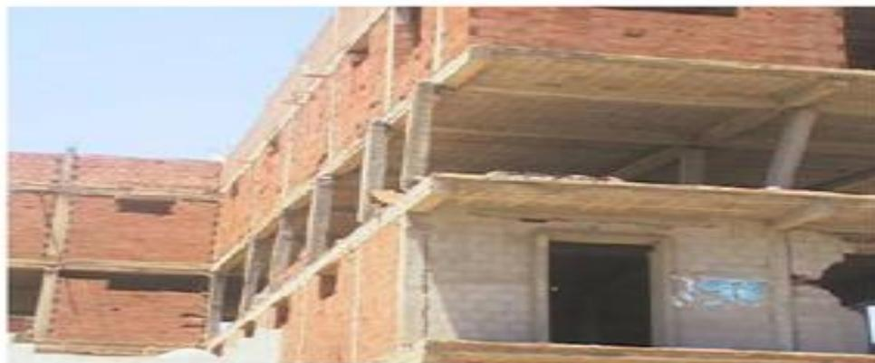
b-Cisaillement des poteaux d'une construction à Bordj el Bahri Séisme de 2003, Boumerdes, Algérie[7]
