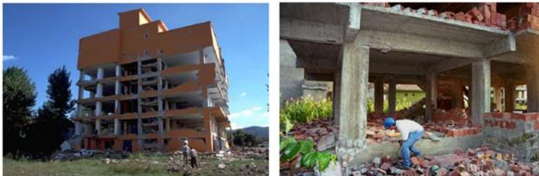
Figure 1.5 : Ruine et chute des murs de remplissage dans les deux directions épargnant l'effondrement du bâtiment après séisme [25]
