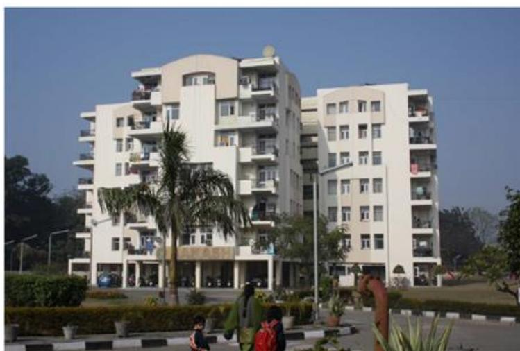
Figure.1.30. Exemple d'un bâtiment sans remplissage au rez-de-chaussée [65] [C.V.R.Murty]
