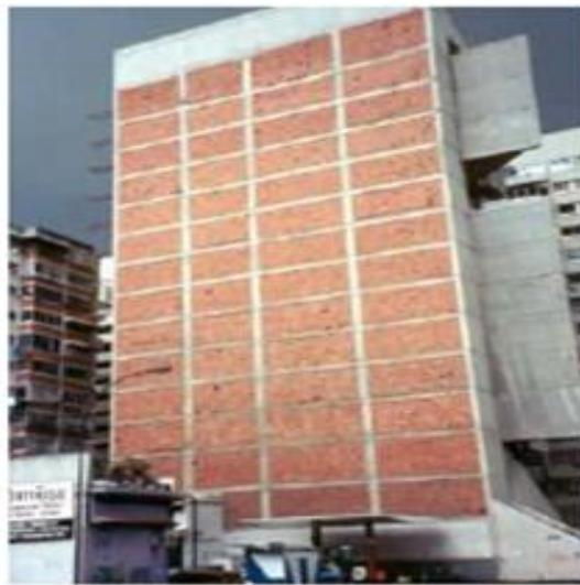
Figure. 1.1. Bâtiment en portiques en béton armé munis de murs de maçonnerie [1]
