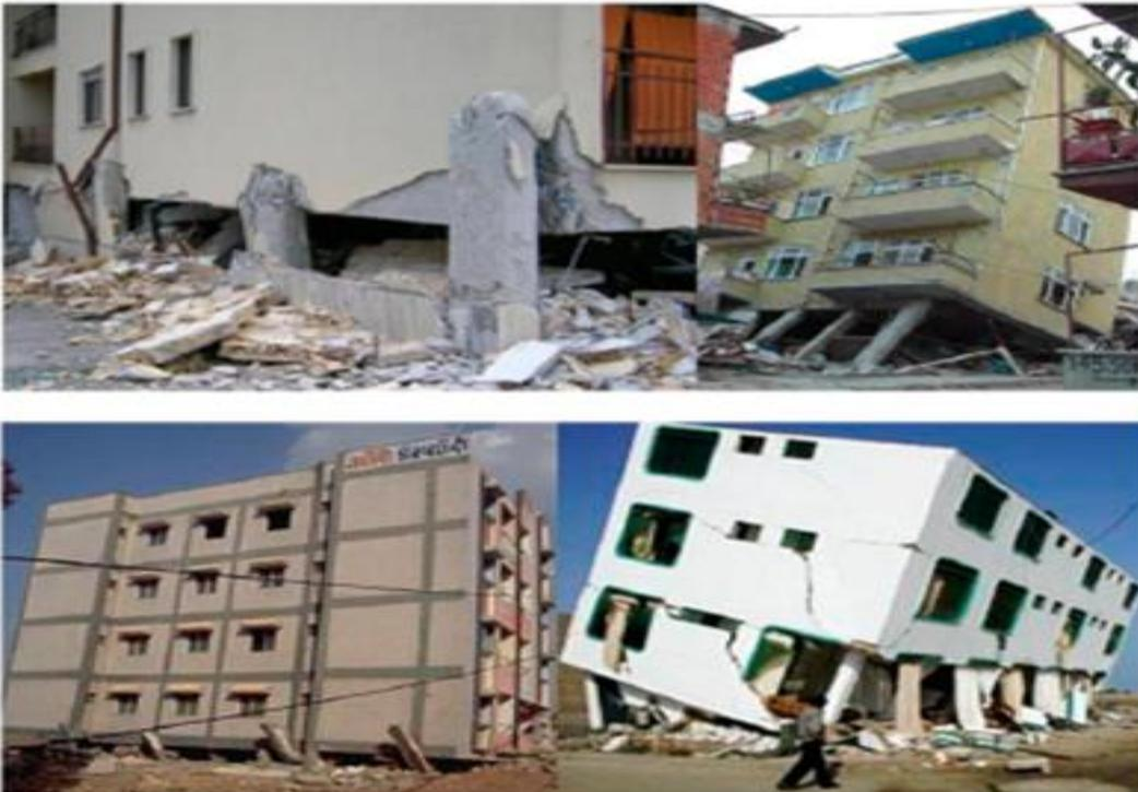
Figure 1.7 : des exemples d'effondrement de bâtiments en raison d'une distribution irrégulière des remplissages sur la hauteur [26]
