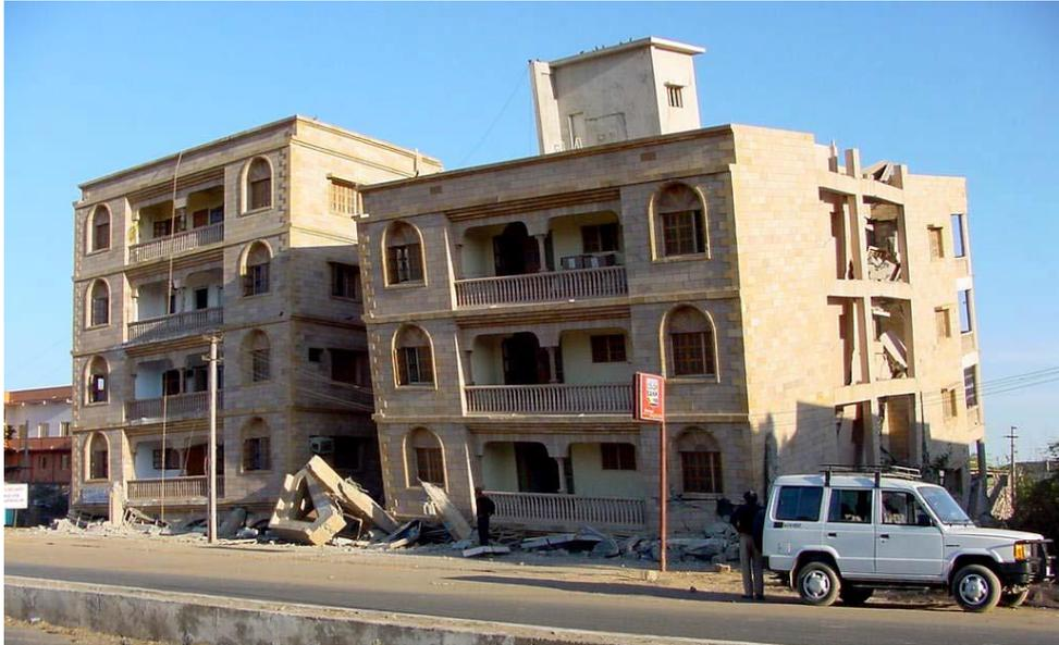
a- Deux Bâtiments en portiques en béton armé avec étage souple au RDC s'effondrent pendant le tremblement de terre de 2001 en Inde [C.V.R.Murty] [64]
