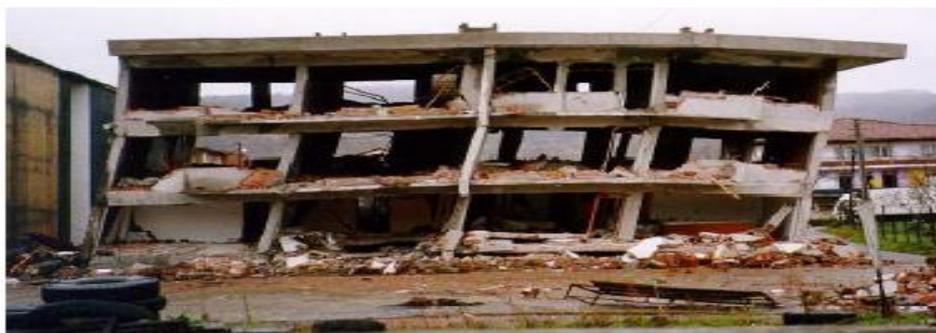
Figure 1.2 : Structure en portiques en béton armé avec des murs de remplissage suite à l'action du tremblement de terre [6]
