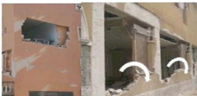
Figure 1.22 : Rupture hors plan des murs de remplissage [54]
