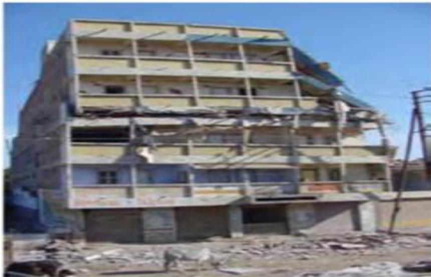
b-Effondrement d'un étage souple intermédiaire-séisme de Bhuj,Inde 2001-[64]
