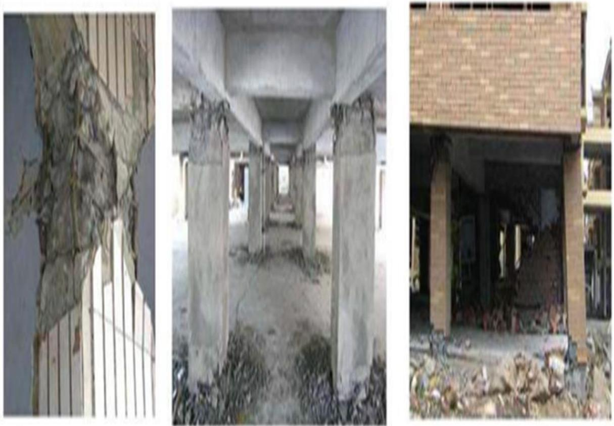
Figure 1.32 : Exemples de rotules plastiques au niveau de l'étage souple à Dujiangyan (Alireza Mohyeddin-Kermani, 2008) [64]
