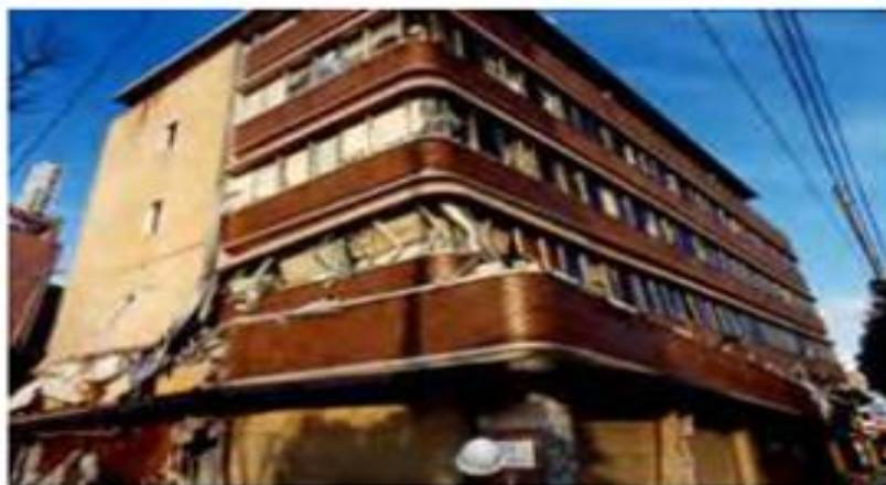
Figure 1.8 : Rupture par torsion du bâtiment en raison d'une distribution horizontale irrégulière des remplissages (Kobe, 1995) [27].
