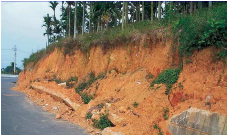
Figure 3-7 Renversement de mur gravitaire[62].
