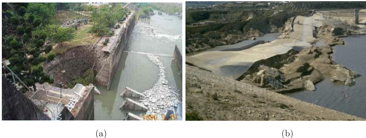
Figure 2 : Exemples de défaillance induite par un tremblement de terre : (a) rupture de mur du barrage de Shin-Kang lors le séisme de Chichi 1999, (b) rupture du barrage inférieur de San Fernando en raison de la liquéfaction des alluvions non consolidées 2 .
