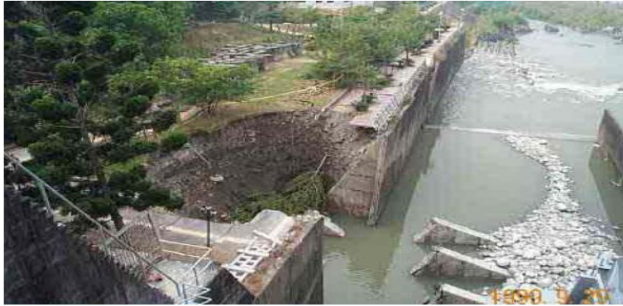
Figure 3-4 Rupture de mur du barrage de Shin-Kang séisme de Chi-Chi 1999[65].
