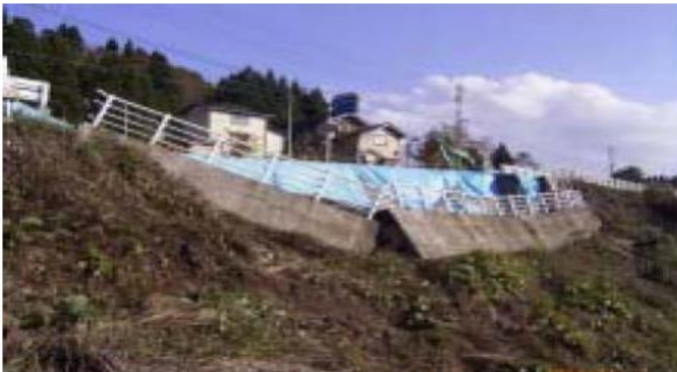
Figure 3-3 Dommages causés à un mur de soutènement en raison d'un déplacement excessif, séisme Niigata-Ken Chuetsu 2004.
