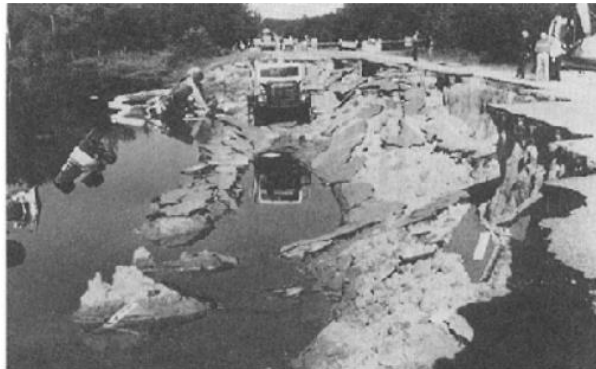
Figure 2-22 la rupture provoquée par la vibration des camions [38].
