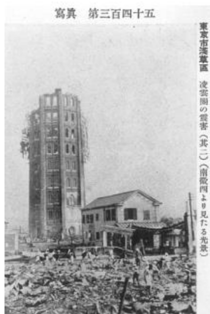
Figure 3-9 Effondrement d'une tour à Tokyo pendant le séisme de Kanto 1923 [70].
