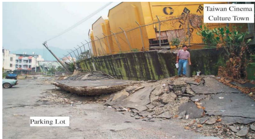
Figure 3-6 Glissement et renversement de la paroi de soutènement[62].
