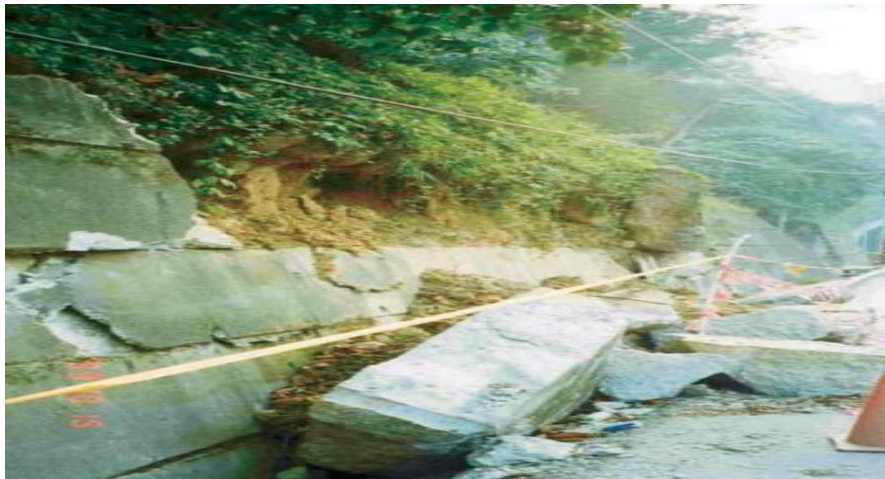
Figure 3-5 Mouvement vers l'extérieur de mur gravitaire le long du joint de construction[65].
