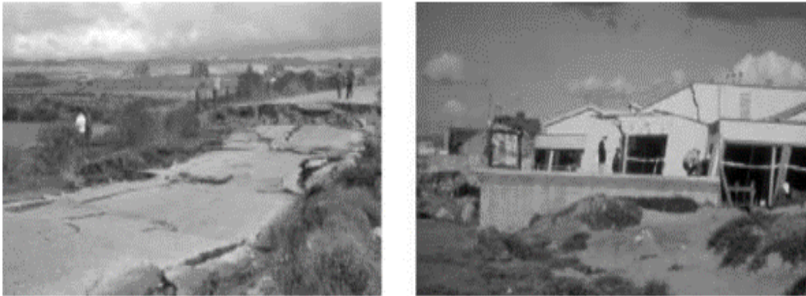
Figure 2-18 Épandage latéral le long de la route Sandholdt (à gauche) et destruction d'un centre de recherche (à droite) à Moss Landing.[32].
