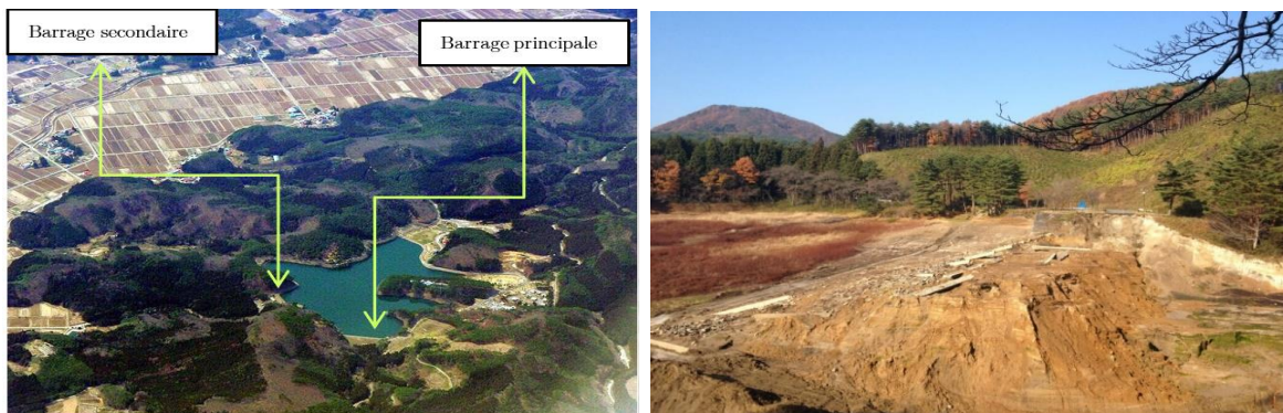
Figure 3-24 Barrage Fujinuma avant et après le séisme (Wiki 2018).
