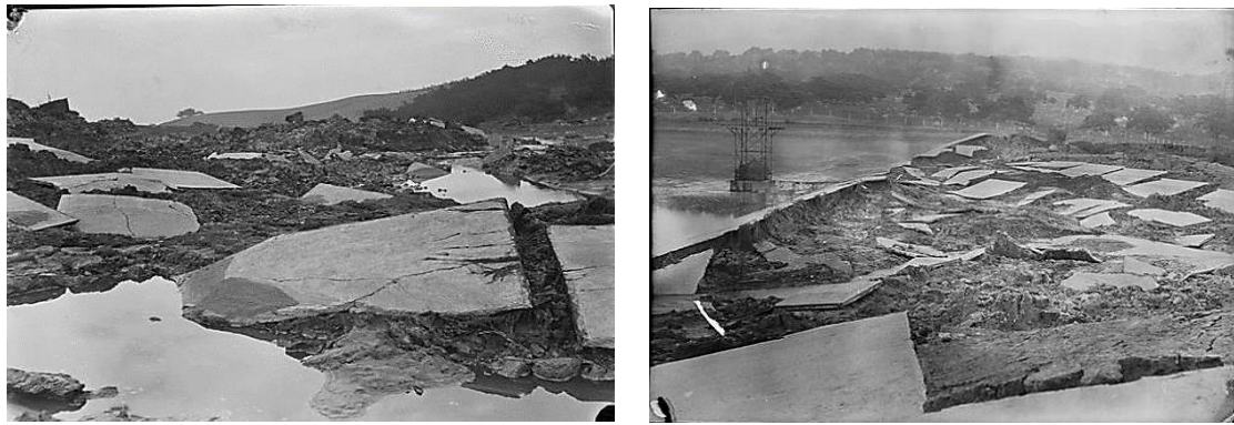
Figure 3-21 Rupture du barrage de Sheffield après le séisme, Santa Barbara, 1925 [104].
