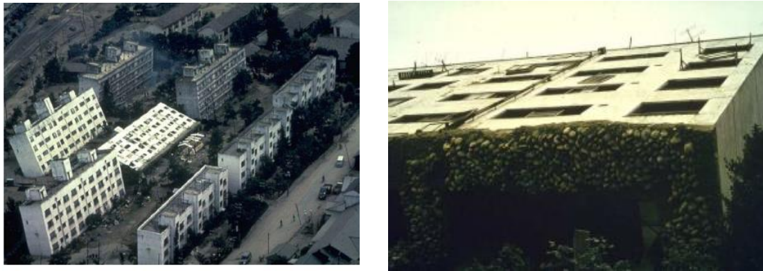
Figure 2-16 Inclinaison des bâtiments Kawagishi-cho à Niigata 1964 [36].
