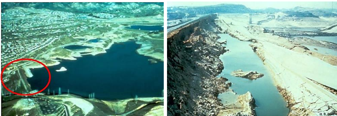
Figure 3-22 Barrage de San Fernando avant et après le séisme de 1971[36].
