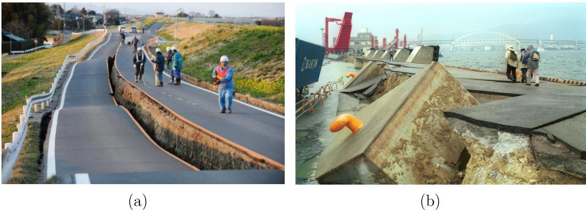
Figure 1. Les ruptures dues à la liquéfaction des remblais dans différents ouvrages : (a) Liquéfaction des remblais d'une chaussée routière 1 , (b) Liquéfaction des remblais du quai d'un port.
