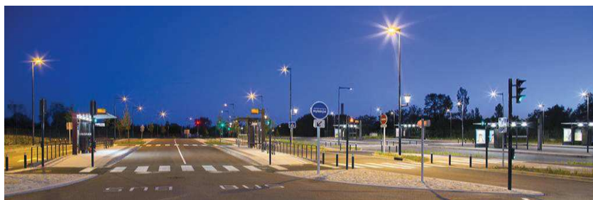
Fig. 2. 27 : L'éclairage public (Ramonville) Source : Boscarri.D et Knusmann. F, 2014
