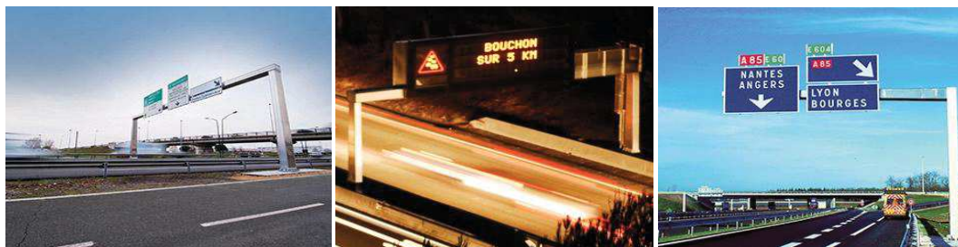
Fig. 2. 26 : la structure métallique à l'entrée de ville (portique /potence)
