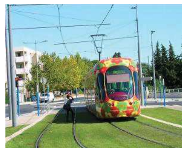
Fig.2.14: voie engazonnée( Le tramway de Montpellier)
