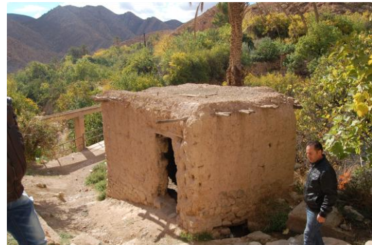
Fig. 4.18 : Le moulin de Mena. (Source : Auteur, 2014).
