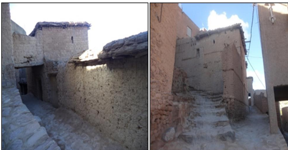
Fig. 4.20: Accès au village Menaâ. (Source : Auteur, 2014).
