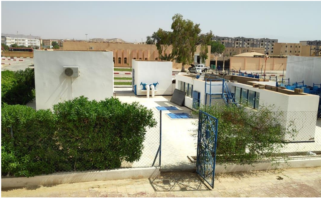
Figure 15: Vue d'ensemble de la station d'expérimentation des modèles réduits.
