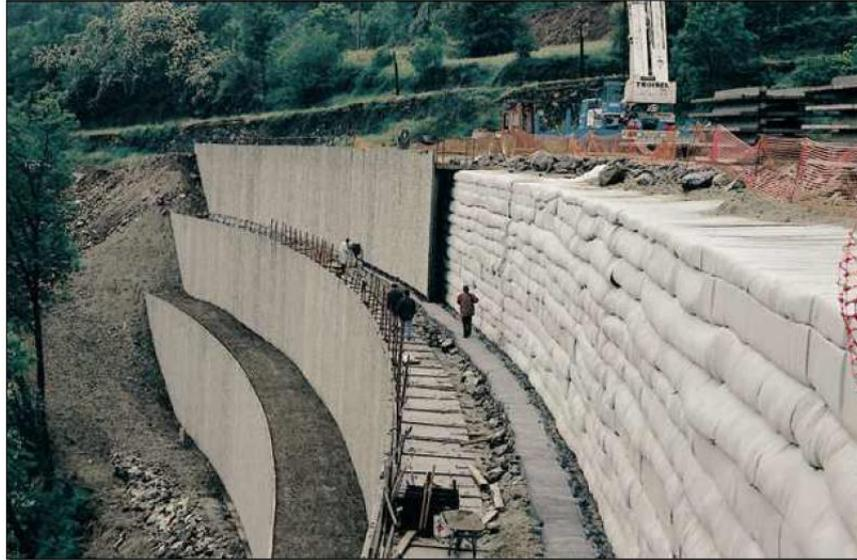
**Photo 1.8 : Parement préfabriqué devant le massif en géotextile**
