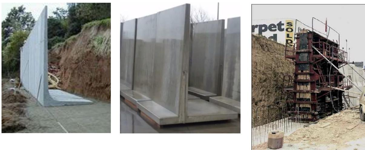
Photo 1.6 : Mur en béton armé encastré sur semelle
