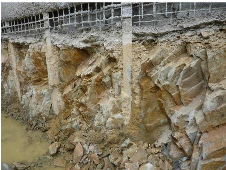
**Photo 1.11 : Photographie d'une paroi berlinoise avec un parement en béton projeté réalisé dans les schistes briovériens [tiré de Tomas le cor(2014)]**
