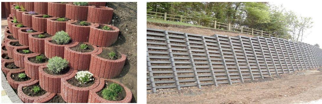
Photo 1.5 : Mur en élément préfabriqués
