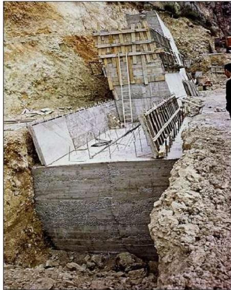
Photo 1.3 : Mur poids en béton
