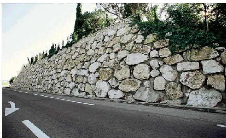
Photo 1.2 : Mur en maçonnerie jointoyée
