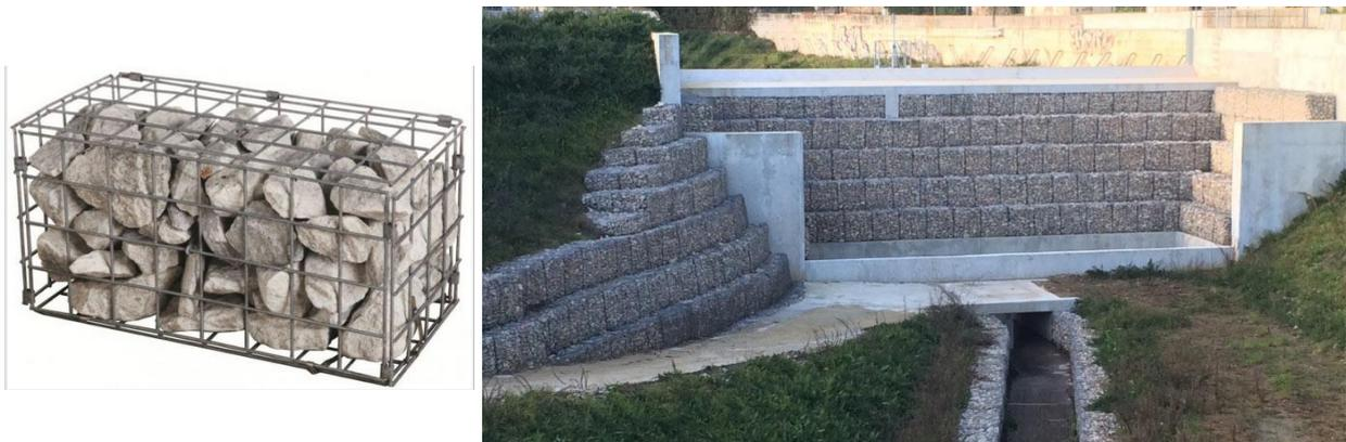
Photo 1.4 : Mur poids en gabion (déversoirs)
