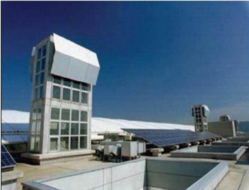
**Figure II.14: Exemple de cheminée solaire intégré sur le bâtiment [Yoshiteru Shinada 2007].**
