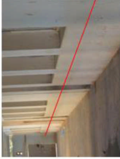
PHOTO : — d'eau des eaux pluviales - l'éconiveau le Sahel Miloud
