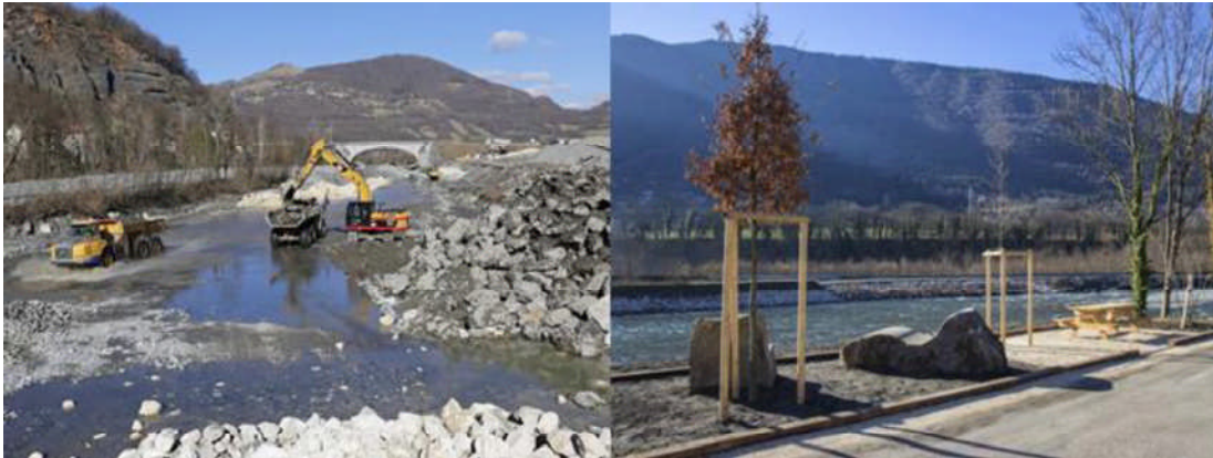
Figure 65-4 Photos sur la ville d'ISÈRE, début des travaux Source : http://www.iseremag.fr/webzine/novembredecembre-2016/lisere-exemplaire-contre-les-inondations#1
