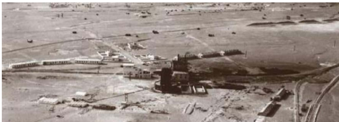
Figure 82-5: Centrale électrique de Bidon II. Source : Collection photos anciennes de Bechar, Edition
