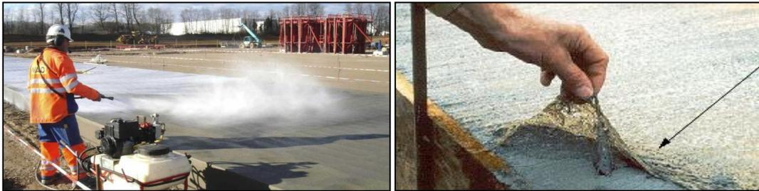
Figure I.20. Application de produit de cure sur surface de béton
