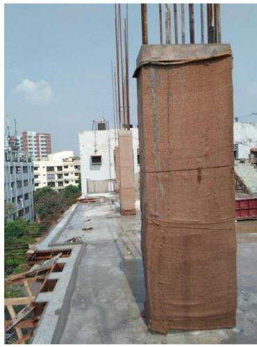
*Figure I.19. Application de revêtement humide sur un poteau*
