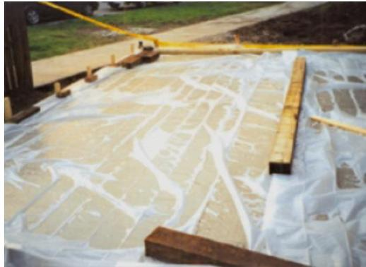
Figure I.16. Recouvrement en film plastique d'un élément horizontal en béton [133]
