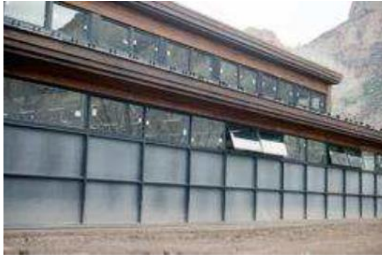
Figure 1-21 : Mur Trombe du parc national Zion, Utah Etats Unis, (Source : Dugue, 2013, p.70).
