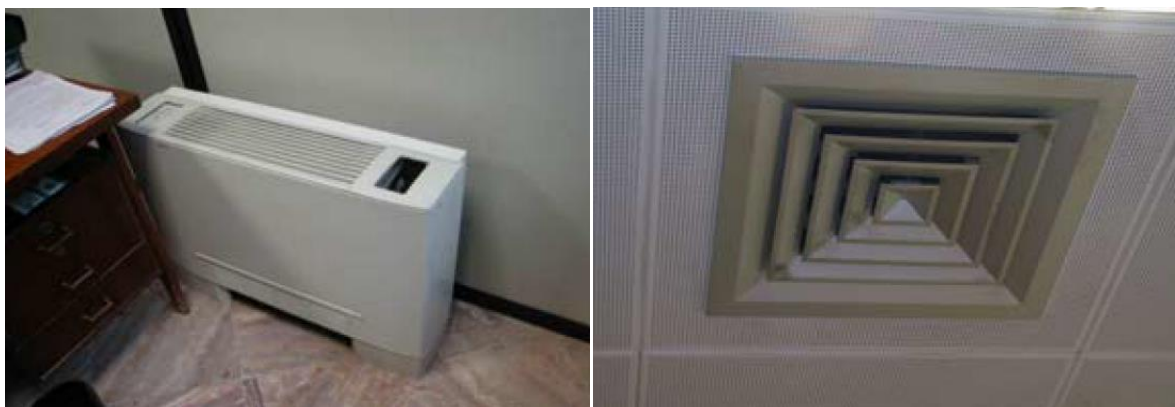
Figure IV-10 : Dispositifs de refroidissement ; ventilo-convecteur à gauche, plafonnier à droite.
