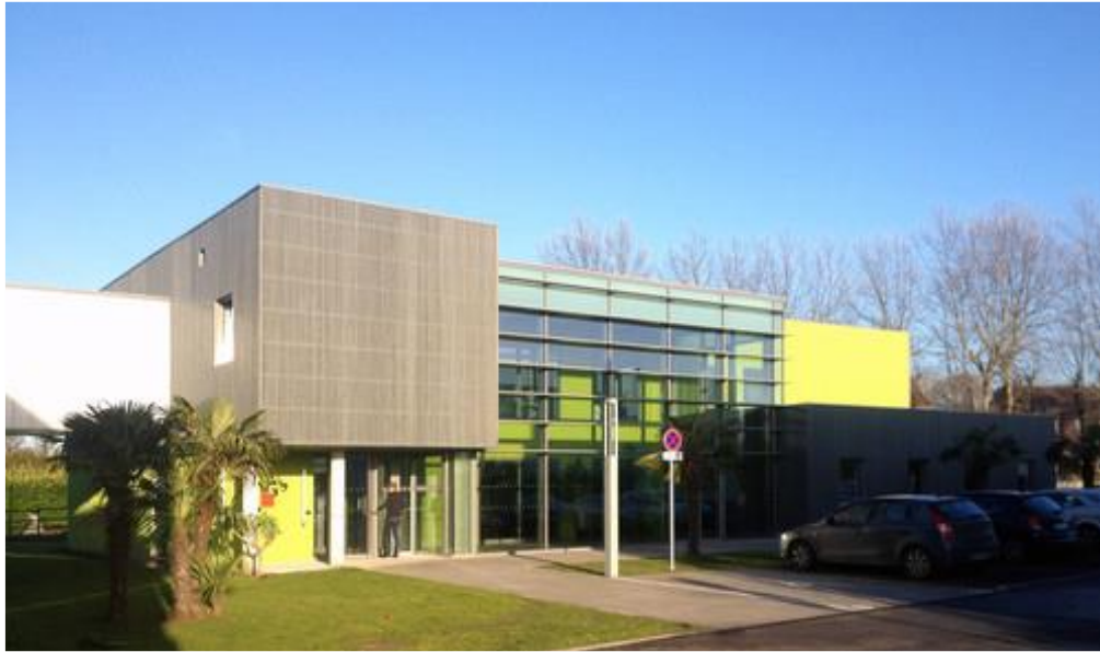
Figure I-23: Serre encastrée du centre de formation et d'examens, à Lille en France.
