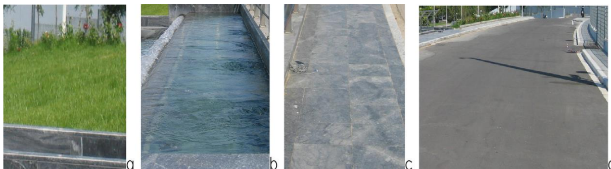
Figure II-6 : Vues sur les matériaux de revêtement du site étudié: (a) gazon, (b) eau, (c) marbre noir et (d) asphalte (Source : Chatzimitriou et Yannas, 2015, p. 12).
