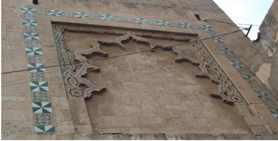
الصورة 25: الجهة الشرقية لجذع منذنة مسجد الباي محمد الكبير المصدر: الباحثة
