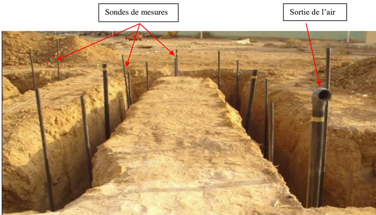
Figure : III. 2 Photo d'une partie de l'échangeur pendant la réalisation
