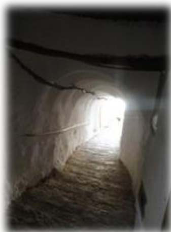
FIG n° III, 18 : Rue couverte, Ksar El Atteuf. Source: la chercheuse, 2011.
