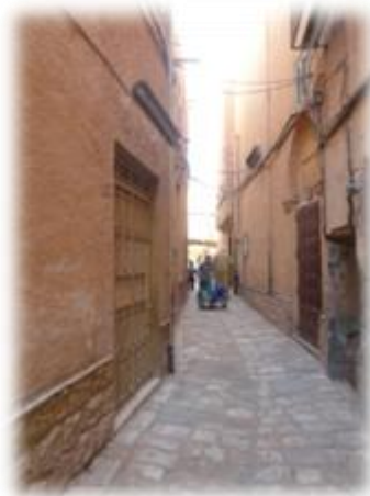
FIG n° III, 16 : Rue principale, Ksar El Atteuf. Source: la chercheuse, 2011.
