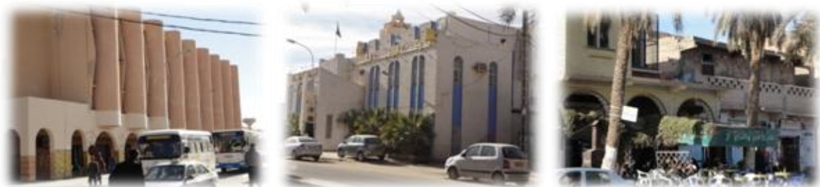
Fig n°VI, 79: le bâti qui entoure la place de la galerie. Source : la chercheuse, 2012.
