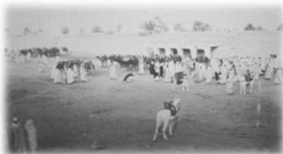
Fig n°VI,40 : la place des martyrs avant la construction des arcades qui l'entourent. Source : Une Oasis saharienne à travers l'histoire Ouargla, 2003.
