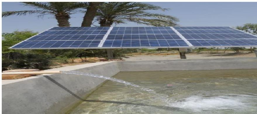
**Figure I.10 : Le pompage d'eau pour l'irrigation des palmiers dattiers par l'énergie solaire dans la wilaya de Biskra (photo originale).**
