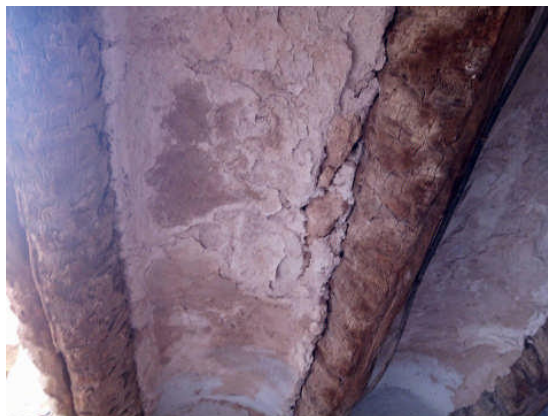
Figure III.12. L'utilisation du stipe comme des poutres à la casbah d'Ouargla. Source: auteur (2017).
