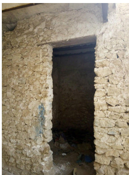
Figure III.11. L'utilisation de la pierre comme matériau de construction à la casbah d'Ouargla. Source: auteur (2017).
