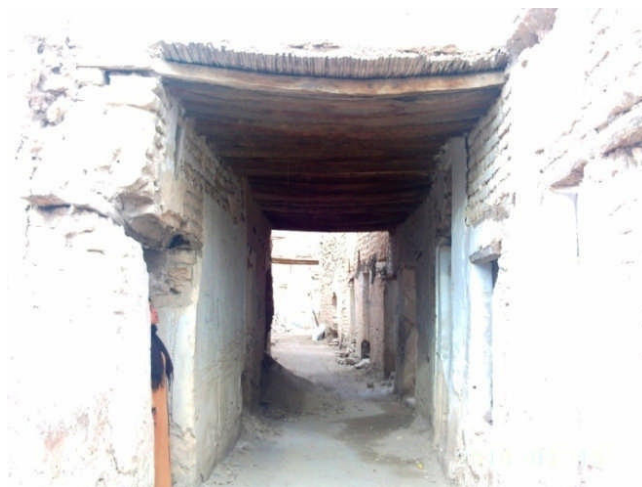
Figure III.14. L'utilisation du stipe taillé comme des poutres au ksar de Lichana à Biskra. Source: auteur, (2017).
