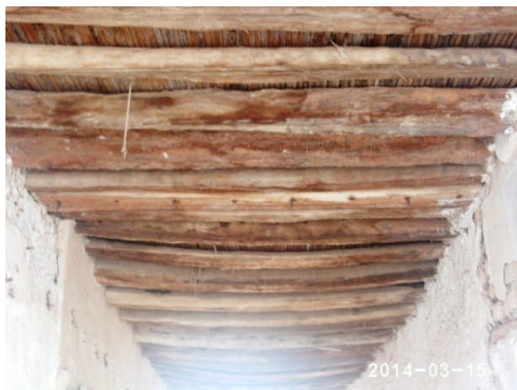
Figure III.15.L'utilisation des gaines comme des appuis au ksar de Lichana à Biskra. Source: auteur, (2017).
