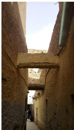
Figure IV.1. Ruelle à El kasbah d'Ouargla. Source: auteur (2018)
