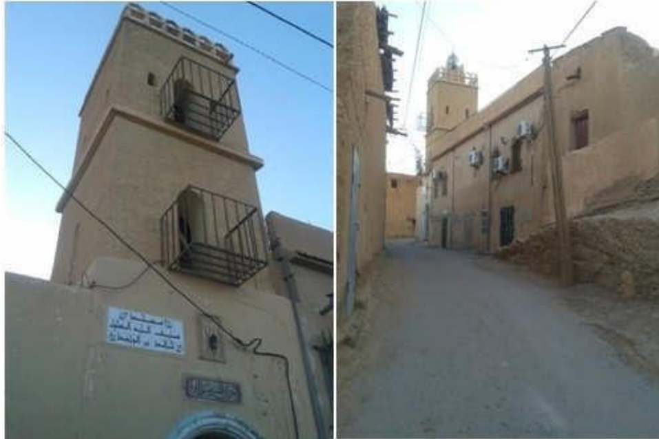
Figure V.19. Vues sur la mosquée BENI OUADJ.
