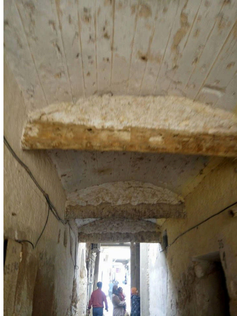
Figure IV.3. Ruelle à El kasbah d'Ouargla. Source: auteur (2018)
