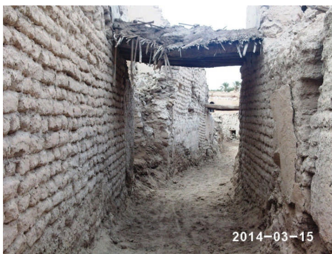
Figure III.10. Construction en Toub au ksar de Lichana à Biskra. Source: auteur (2014).
