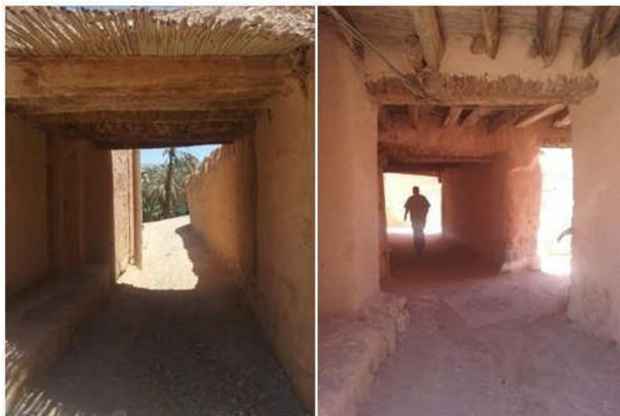
Figure V.15. Les passages couverts dans le Village Rouge.
