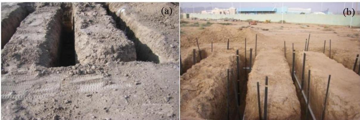
**Figure 5.1.** Photos de l'installation expérimentale de l'ECSHAS à l'Université de Biskra, sud de l'Algérie 34 ° 47'N-005 ° 43'E : (a) un trou en forme de serpentín; (b) Conduit horizontal en PVC enterré avec thermocouples.
