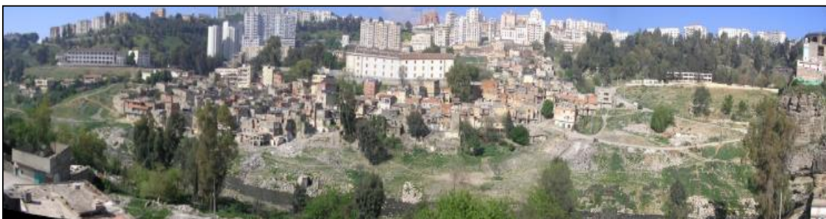
Figure 14: Terrain du parc de Bardo avant l'intervention (Archive de l'auteur)
