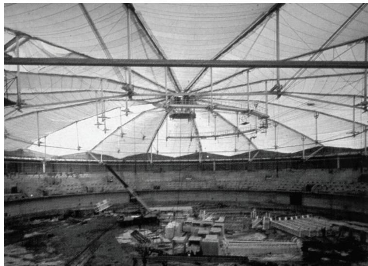
Figure N°1.5 : Arène olympique en construction.
