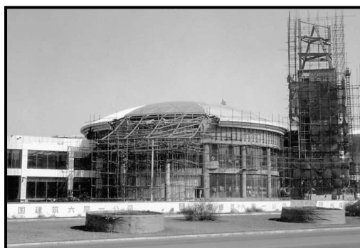
Figure N°1.10 : Construction d'un dôme suspendu en chine [WEN03]
