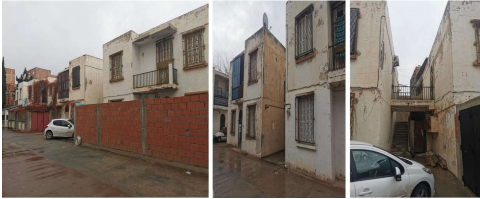
Figure III-22: des vues à l'intérieur des ilots (Cité Naaman DJEFFAL)
