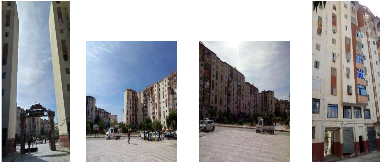
Figure III-19: vues sur les espaces extérieurs de la cité KAHOUL Rachid.
