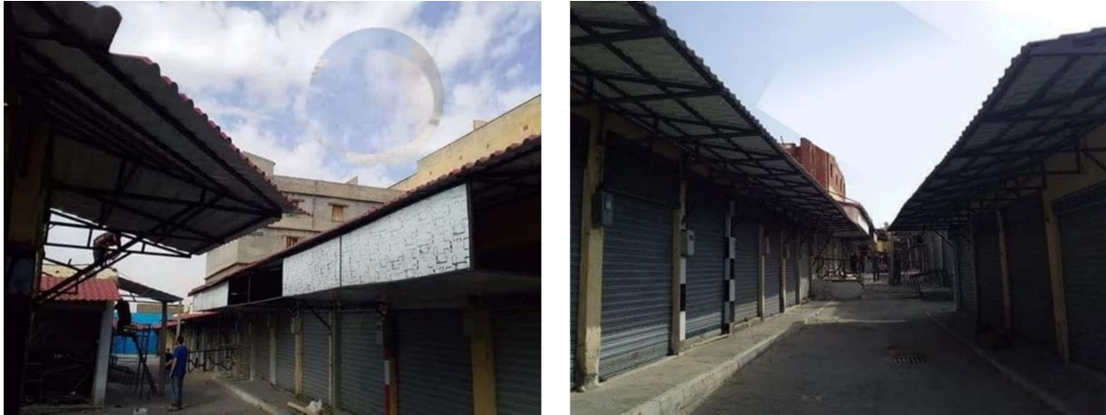
Figure II-3: Couvrement des parties des chemins au marché couvert à El Eulma.
