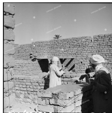
Photo 10 : La participation de la population locale dans la construction des habitations
