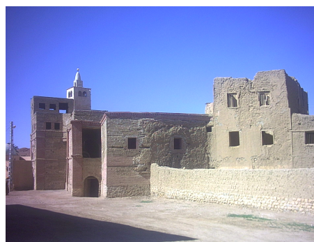
Photo 21 : La Sraya, après sa restauration (2010)
