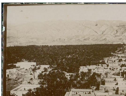
Photo 6 : Khanguet Sidi Nadji (1923) avant la construction des demeures notables
