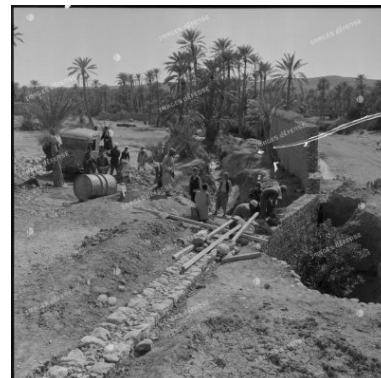
Photo 12 : l'édification du mur d'enceinte dans la palmeraie (côté Ouest) par la population locale
