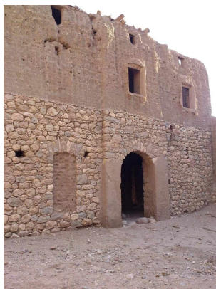
Photo 23 : L'utilisation de la technique mixte des matériaux (premier niveau en pierres et le deuxième en briques de terre crue)
