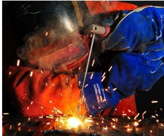
Figure II.6 Soudage à l'arc électrique [7].
