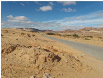
Photo V-4 : La voie principale de Maitar dégradée et envahie par les dunes (Sources : Auteur, 2020)
