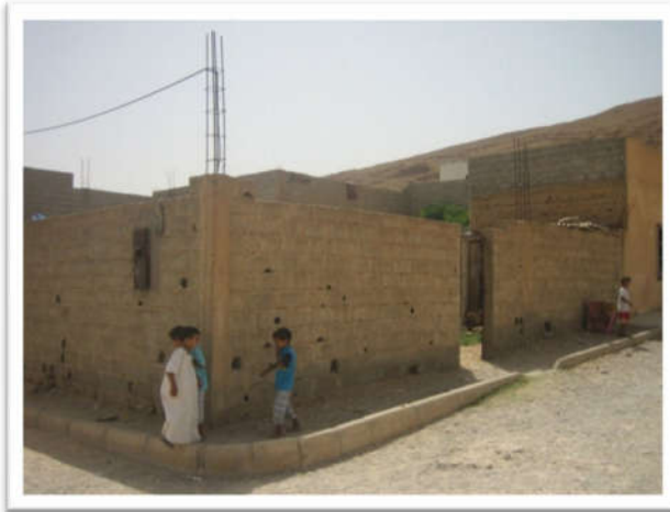
صورة قبل عملية الترميم
