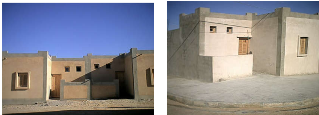
Photos VII-18, VII-19: Cellules de logement réalisées dans le cadre de l'opération R.H.P (Source : A.A.D.L M'Sila, 2003).
