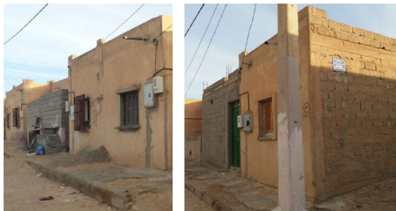
Photos VII-27, VII-28 : Transformations sur la cellule de logement avec un changement partiel de l'aspect extérieur initial et l'occupation de l'espace de la véranda. (Source : Auteur, 2018).
