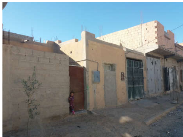
Photo V-8 : Modifications spontanées sur les cellules de relogement de l'opération R.H.P (Source : Auteur, 2020).
