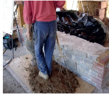
Photo n°67 : La terre est mélangée avec des végétaux, puis piétinée avant d’être mise en œuvre. Source : https:// : www.approche-ecohabitat.org/images/...../Ecopole/C6_bauge_v2.pdf Consulté le 22/02/2018.
