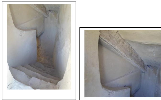
Photo n°101 : Escaliers d'une habitation dans le Ksar confectionné en maçonnerie et tronc de palmier. Source : Auteur.2022.
