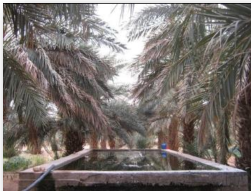
Photo n°27 : Bassin en béton venant remplacer l'ancien "Madjen". Ouled Aissa, Adrar. Source I. Salem, 2011.
