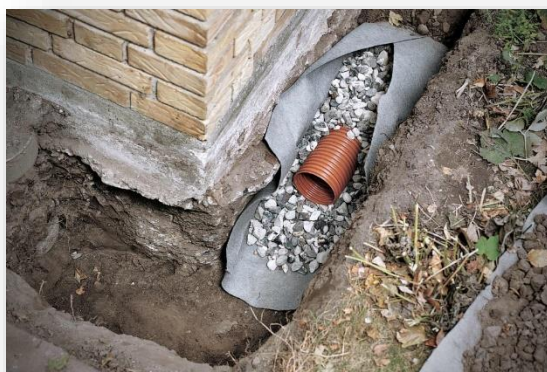
Photo n°164 ° : Drainage extérieur. Source : https://www.hornbach.ch/projets/evacuation-de-l-eau-par-drainage . Consulté le 05/02/2022.
