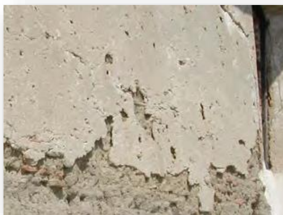
Photo n° 56 : Enduit à la chaux lissé, Tarn-et-Garonne Source : CAUE de l'Ariège, CAU E des Hautes-Pyrénées -, 2011.
