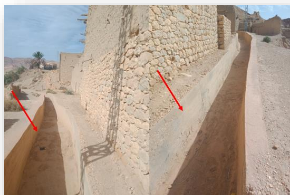
Photo n°161 : Digue reprise en 2009 dans le cadre des travaux de réhabilitation. Source : Auteure 2022.
