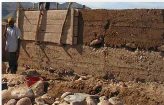
Photo n° 66 : La technique de la bauge. Source : Global Archiconsult. 2013.
