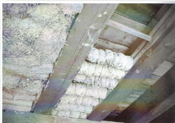
Photo n°62 : Torchis d'isolation disposé dans les vides de la structure d'un plancher en bois. Source : B. Pignal.2005.
