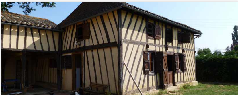
Photo n° 58 : Construction en torchis. Source : Anaïs Chesneau. 2014.
