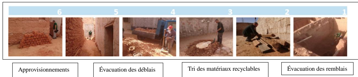
Fig. n°63 : Les points clés pour organiser le chantier de réhabilitation. Source B. Rakotomamonjy. 2019.
