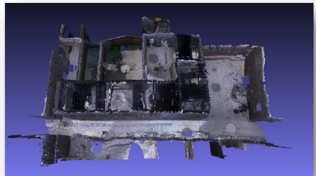
Fig. n°128 : Image 3D texturée rendue par Mesh Lab montrant l'état de détérioration de la toiture. Source : Auteure.2022.
