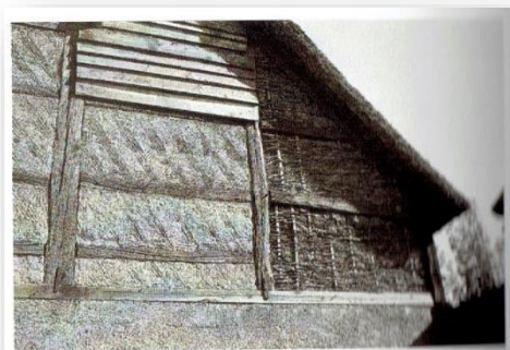
Photo N° 63 : Le torchis à différents stades de finition. Source : B. Pignal.2005.
