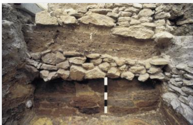
Photo n° 54 : Superposition de murs en adobe avec soubassements en pierre. Source : TERMaghreb, 2014/ 2016.
