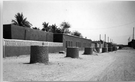
Photo n°5 : Alignement des puits d'une foggara à Timimoune. Source : B. REMINI, 2008.
