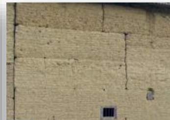
Fig. n°45 : Principe constructif du pisé. Source : J-F. GARDÈRE.2012.
