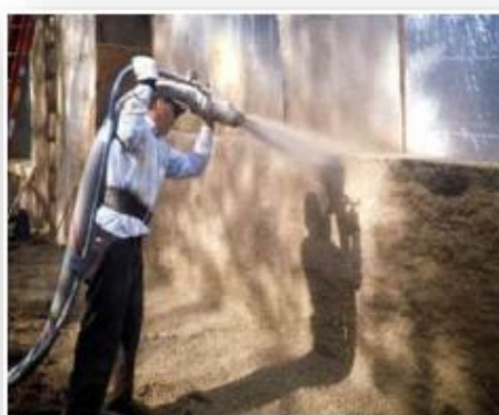
Photo n°61 : Terre projetée. Source : Auroville Earth Institute http://www.earthauroville.com/projetedearth en PHP (consulté en Juin 2013)
