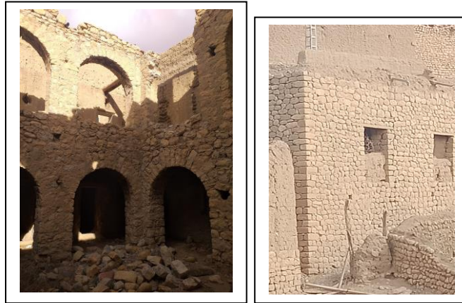
Photo. N° 94 : Murs extérieurs confectionnés entièrement en pierres de l'Oued El Arab. Source : Auteure. 2020.
