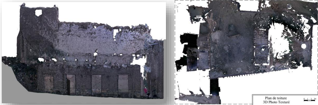
Fig. n°113 : Façade Nord et plan de toiture 3D photo texturée montrant l'érosion de tête et surface des murs. Source : Auteure.2022.
