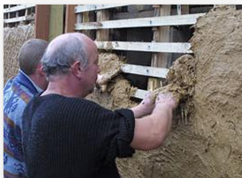
Photo n°60 : Mise en place du torchis. Source http://www.echo62.com /article-reprendre-le flambeau-du-torchis. (Consulté en Juin 2013).
