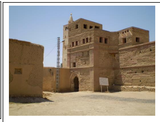
Transformation de la Saraya après l'intervention. Source : Auteure.2021.
