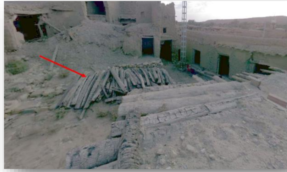
Photo n°151 : Poutres en bois de palmier récupérées avant l'intervention sur la salle de prière de la mosquée. Source : Auteure.2022.
