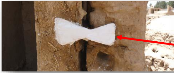
Photo n° 174 : Contrôle de fissures avec la mise en place de témoins. Source : CRAterre-ENSAG.2010.
