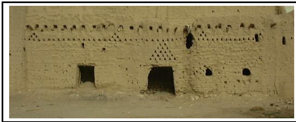
Photo n° 95 : Façade d'une habitation dans le Ksar de Khanguet Sidi Nadji décorée avec de la bouillie d'argile. Source : Auteure. 2007.
