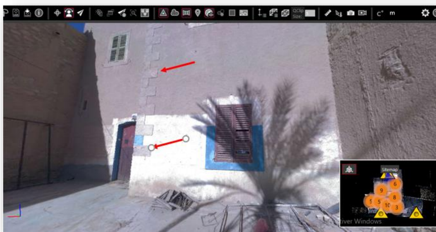
Photo n° 169 : Photo JetStream de la façade sud de la maison Ben Hassine dont l'angle est renforcé avec la pierre. Source : Auteure.2022.
