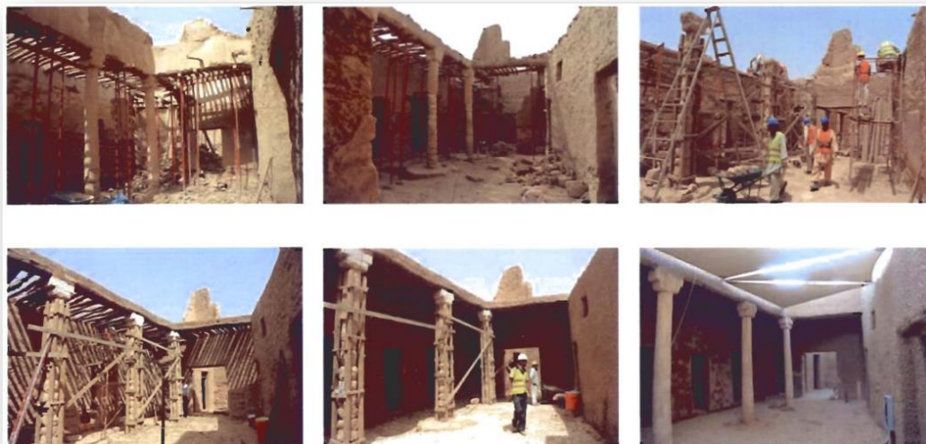
Photo n°167 : Exemples de travaux de protection avant l'intervention (pose d'étais). Source : M. Bendakir.2012.
