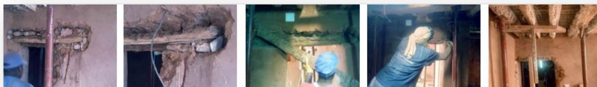
Photo n°178 : Opération de remplacement de linteau. Source : Laboratoire CRAterre. 2019.
