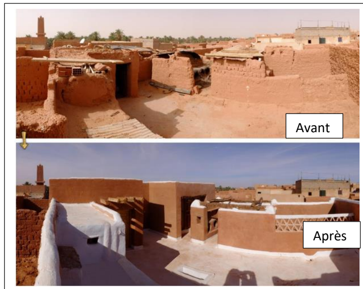
Fig. n°68 : Résultat après application des enduits de finitions. Source : B. Rakotomamonjy. 2019.
