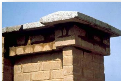
Photo n°177 : Eléments préfabriqués pour protection de l'acrotère. Source : S. Moriset .2011
