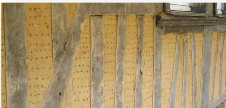
Photo n° 59 : Structure porteuse en torchis. Source : Olivier Myriam et AL. 2016.
