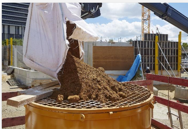
Photo n° 71 : La mise en œuvre mécanisée du pisé.
