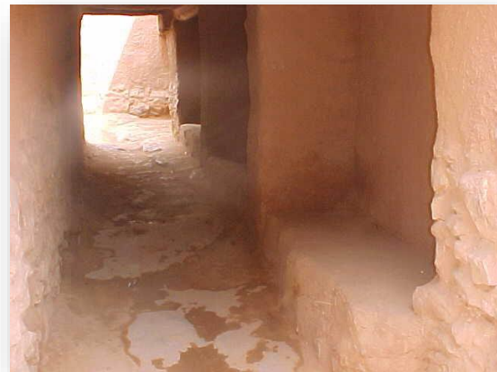
Darb aménagé par des dkakan (banquette) à Taghit (2003)
