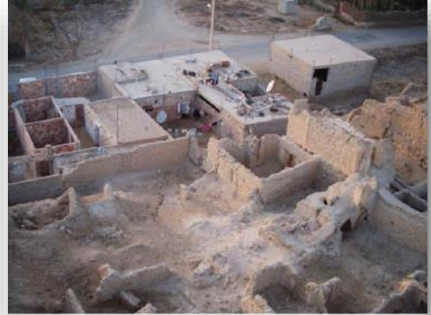
Photo n° 35 : Nouvelles habitations viennent s'adosser à côté du ksar en parpaing, béton... Source : Y. Kouzmine.2007
