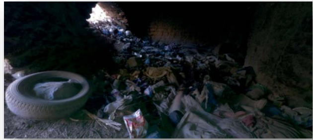
Photo n°125 : RDC des locaux de commerce et hammam bondés de débris causé par l'homme. Source : Auteure.2022.
