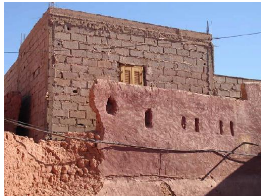
Photo n° 33 : Transformation du mode de construction dans le ksar de Timimoune. Source : B. Yousfi.2012.
