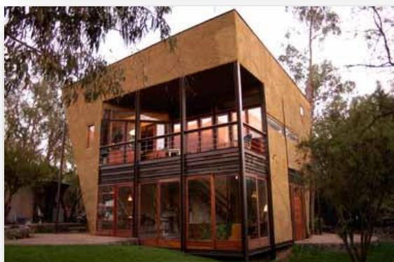
Photo n°75 : Construction en ossature métallique et torchis réalisée par l'architecte chilien Marcelo Cortes. © M. Cortes Source : CRAterre, T. Joffroy et Al.2020.
