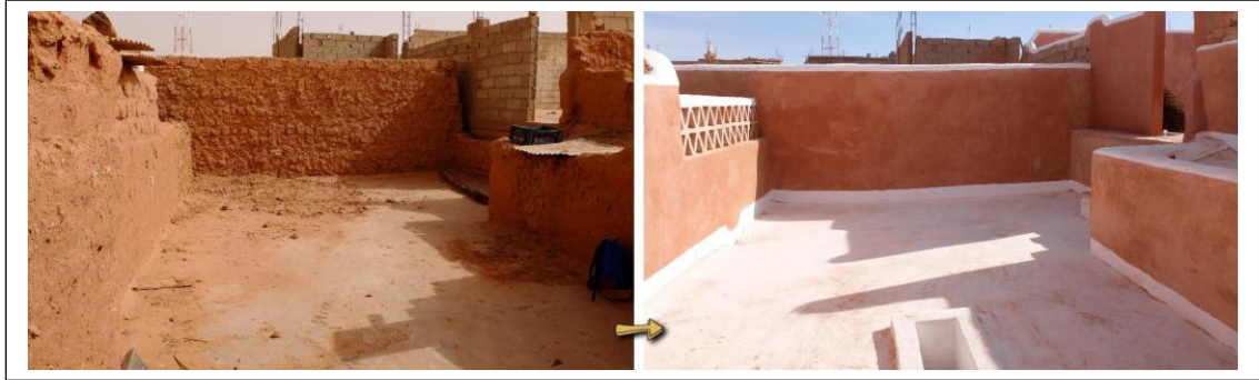
Fig. N°66 : Toiture palmier terre après travaux. Source : N. Sanchez Munoz et Al. (.2019).
