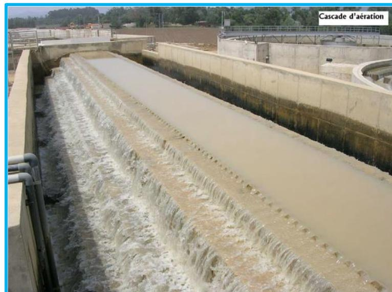
**Figure 17** : Cascade d'aération de la station de traitement d'eau Potable de Koudiat Medouar.
