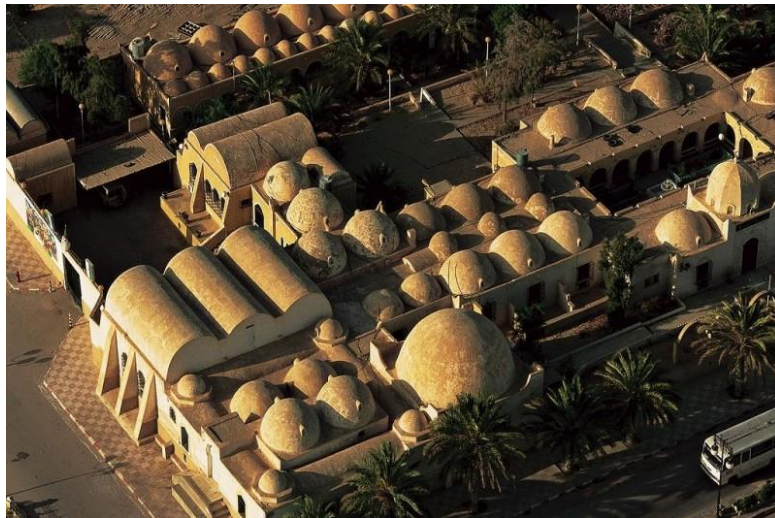
Figure IV.2 : Dômes et voutes utilisée à l'Oued (source : le Sahara a vol de oiseau)
