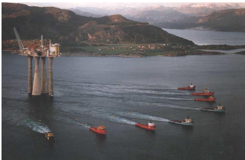
Figure 1.1 Exemple d'une plate-forme à base gravitaire, (Puech, 2004)
