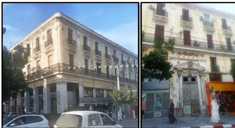
Photo 16 : Immeuble d'habitation au centre-ville colonial de Guelma. Auteur 2022.
