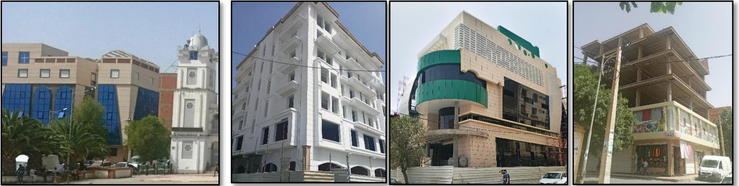
Photos 8-9 : Immeubles récents d'investissements au centre-ville de Khenchela. Source : Auteur 2022.
