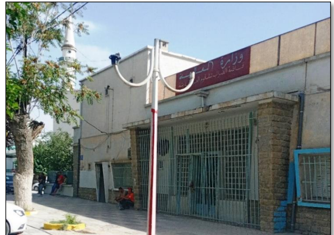
Photo 22 : Siège des contributions du centre-ville de Chalghoum Laid source : auteur 2022.
