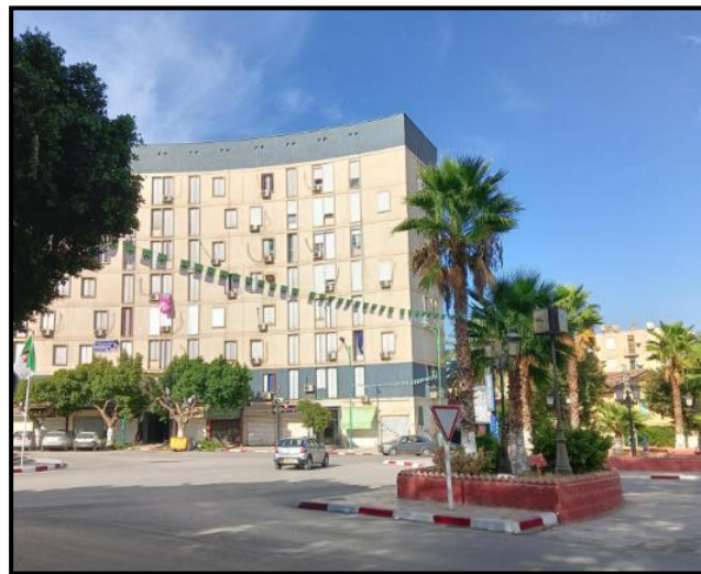
Photo 17 : Immeuble d'habitation au centre-ville colonial de Guelma. Auteur 2022.
