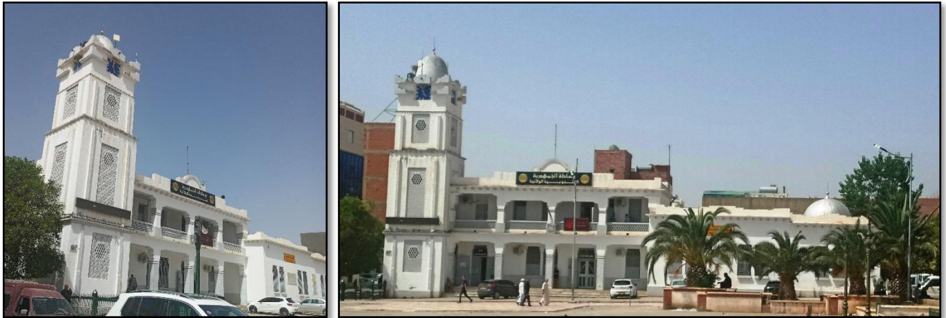
Photo 1 : L'ancienne mairie de Khenchela. Source : Auteur 2022.
