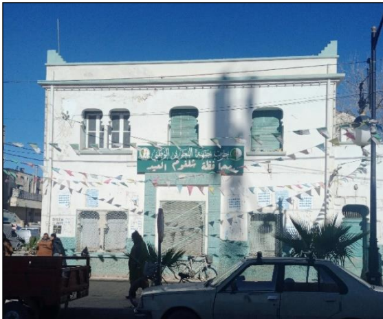
Photo 22 : ancienne maison des combattants. Source Auteur 2022.
