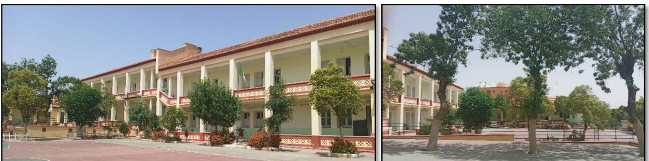
Photo 3 : École Ait Zaouche de Khenchela (Photos d'intérieur) Source : Auteur 2022.
