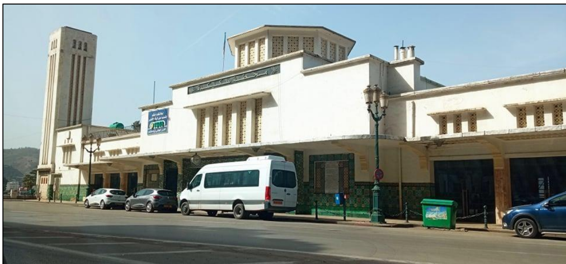
Figure I. 3 : Vue de la façade principale de La gare ferroviaire de Skikda
