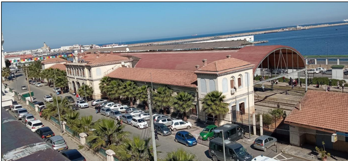
Figure V. 6. Vue sur la gare centrale d'Alger depuis le boulevard de l'impératrice
