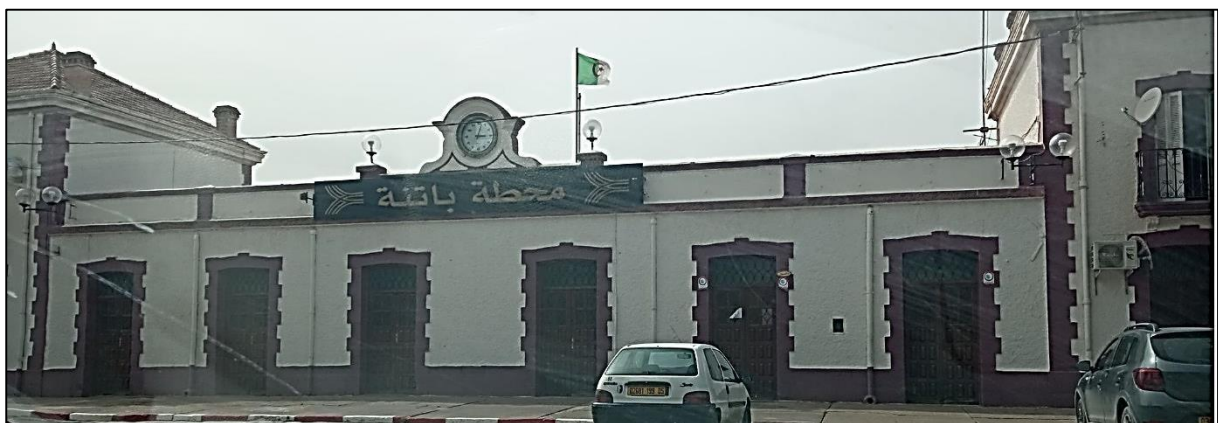
Figure V. 24. Vue de l'entrée de la gare ferroviaire de Batna depuis la cour
