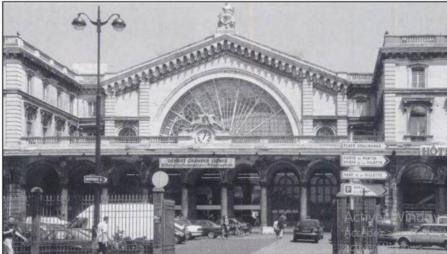
Figure III. 4. Gare de l'Est Paris
