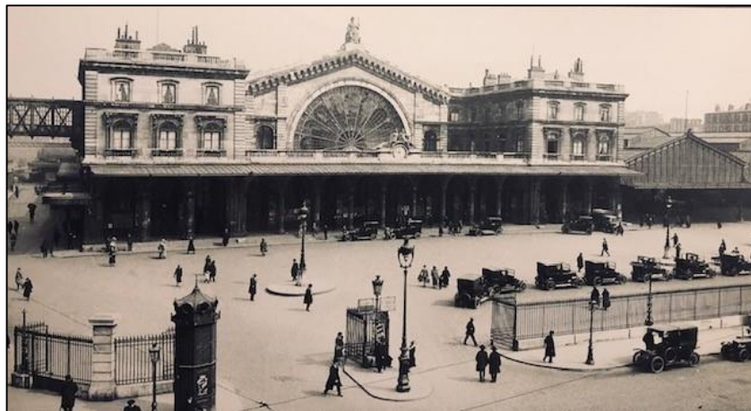
Figure III. 15. Vue de la façade de la gare de l'Est en 1910, Paris
