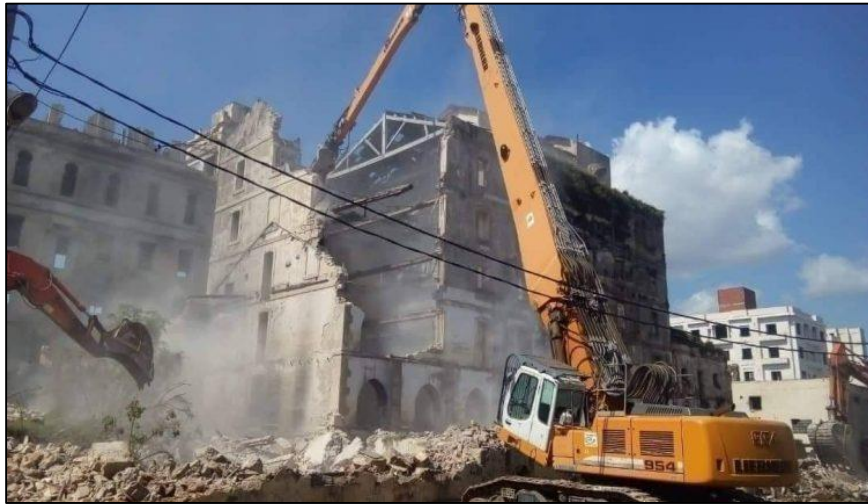
Figure I. 1 : Démolition du bâtiment moulin NARBONNE, Alger, avril 2022
