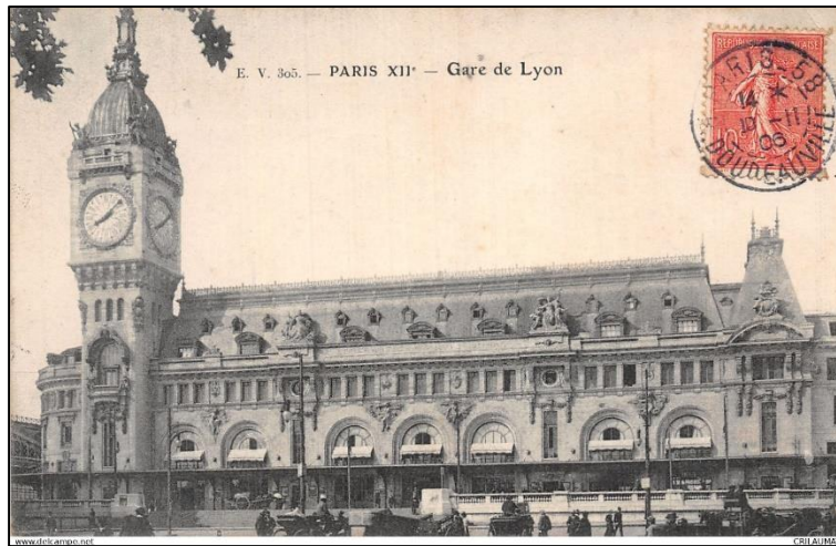
Figure III. 17. Carte postale de la gare de Lyon, Paris Vue du beffroi
