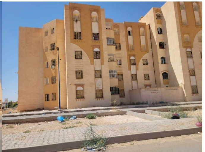
Figure 80 : Façade Est des 150 LPA. Source : Auteure, 2022.
