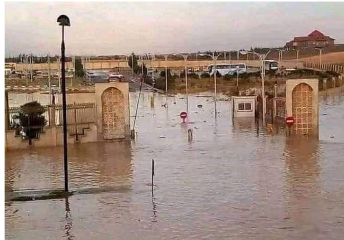
Figure 143 : La Gare Routière de la frange urbaine Nord-Est inondée. Source : Djelfainfo.dz, 2018.
