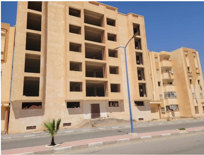
Figure 79: Façade Sud des 150 LPA (vue sur la clinique en cours de réalisation). Source : Auteure, 2022.
