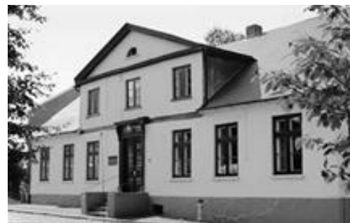
Figure : I. 6 la terre enfouée maison, Meldorf, Allemagne, 1795 [02]
