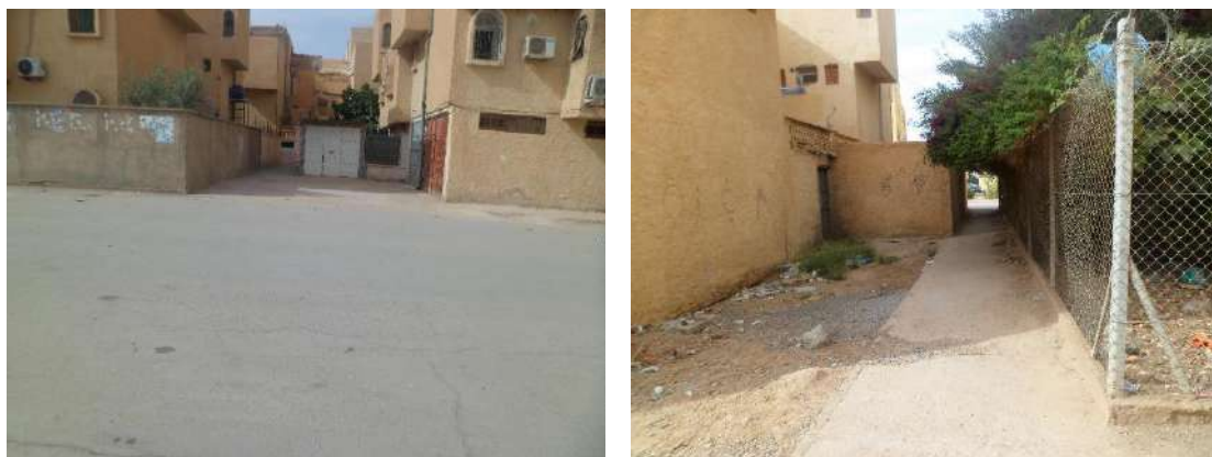
Fig. 6-20 : Photos indiquent l'appropriation illicite des passages de la partie des 135 logements semi-collectifs comme abris ou vérandas. Source : Auteur.
