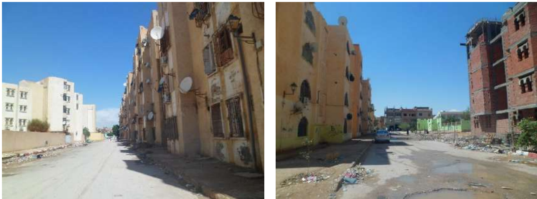
Fig. 6-49 : Photos de la rue périphérique ouest de la cité. Source : Auteur.
