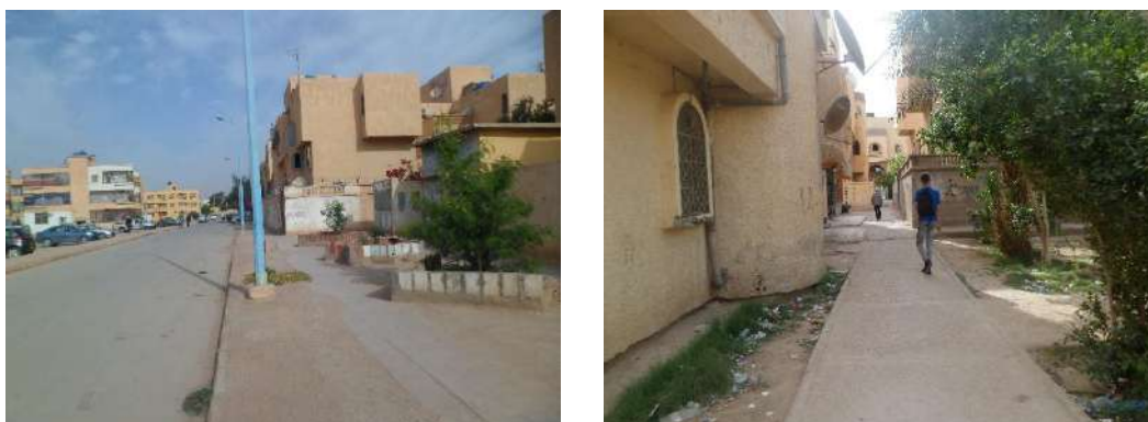
Fig. 6-25 : Photos indiquent les trottoirs d'une rue intérieure et un passage. Source : Auteur.
