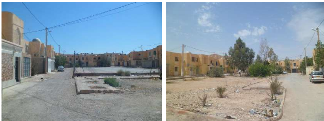
Fig. 6-35 : Photos montrant l'état abîmé du terrain de sport et l'aire de jeu. Source : Auteur.
