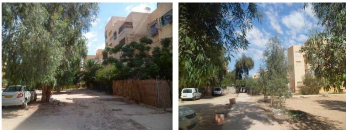
Fig. 6-65 : montrent l'état dégradé d'aménagement extérieur en particulier les trottoirs. Source : Auteur.
