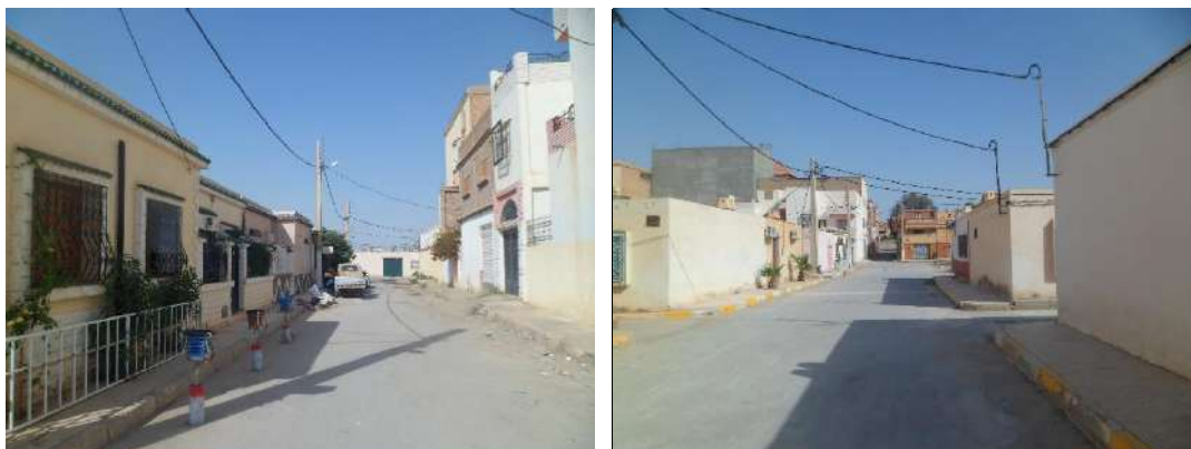
Fig. 6-17 : Photos indiquent les trottoirs des rues intérieures de la cité de l'Indépendance.
