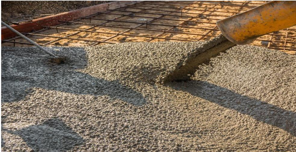
**Photo2.1 : Béton autoplaçant, les gravillons nagent sans aucune ségrégation**
