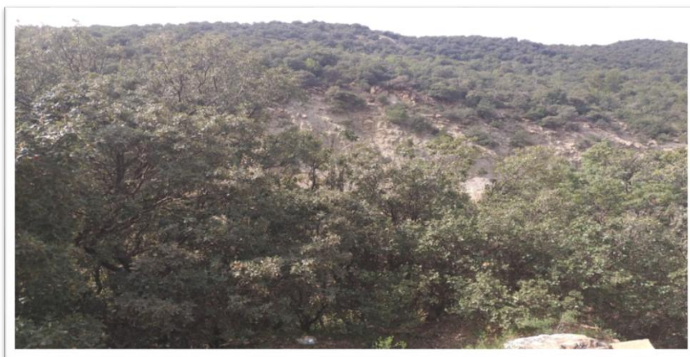
Figure 9 : Vue générale de la station de Boumerzoug (Clichet personnel ,2019).
