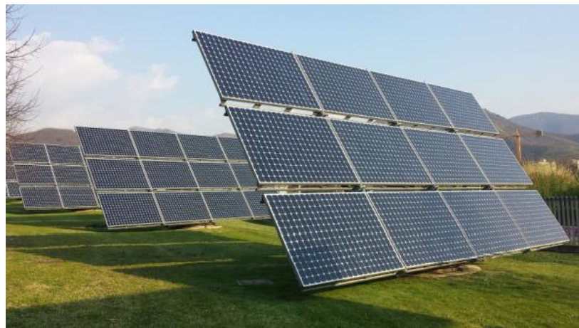
Figure 2.4. Masque proche (cas d'une rangée de modules PV du même GPV)
