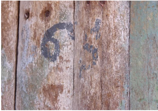
(ب): تشرخ الخشب (النخيل) وإنفصال أجزاءه بسبب فقدان محتواه المائي بفعل التعرض المباشر لدرجات الحرارة، قصر كرفال شروين
