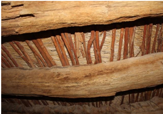
(ب): التسقيف بإستعمال جذوع وأغصان أشجار الرتم
