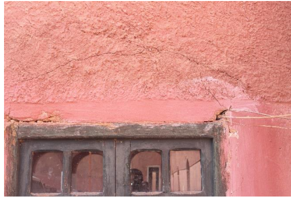
(ت): تشرخ وإنفصال الملاط نتيجة تمدد العوارض الخشبية بأعلى نوافذ، مقر المركز (CAPTERRE)
