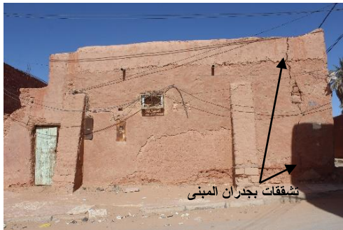
(ث): دعامات إنشائية بارتفاع جدران المبنى، منزل جهة بأحراش، قصر تيميمون
