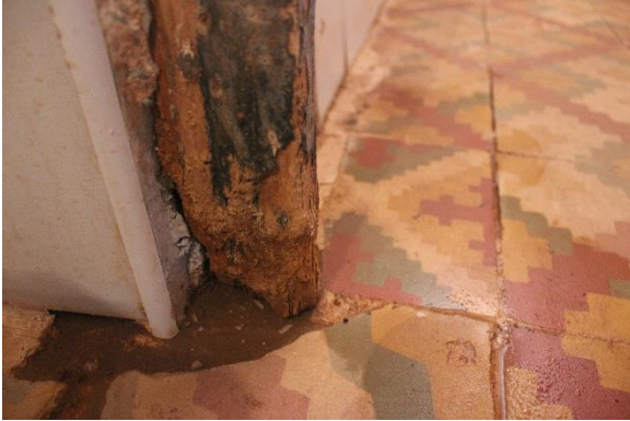
(ب): تأثير الرطوبة/المياه على تلف أحد العوارض الخشبية (الخشب الأحمر)، مقر المركز (CAPTERRE)
