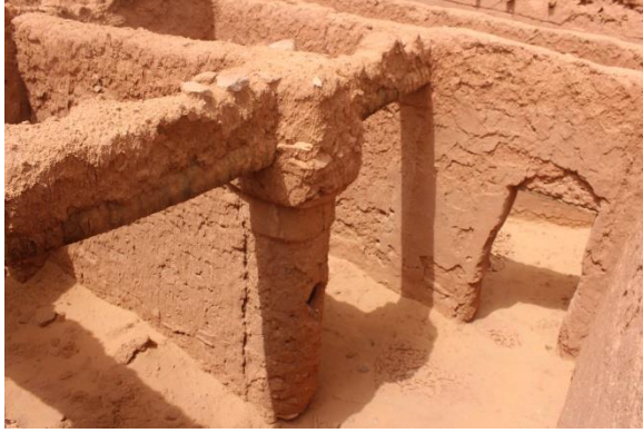
(ت): تساقط جزء من السقف بعد ركود مياه الأمطار به ونفاذها خلاله، دار القايد بأولاد عبو دلدول (ث): تساقط جزء من الملاط الخارجي (التليس) نتيجة التسرب المستمر لمياه الأمطار بين سطح الجدار وطبقة الملاط، قُصبة أورير دلدول
