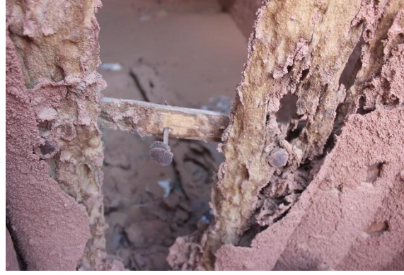
(ت): مظاهر الإصابة بالنمل الأبيض "تيمدي" على إحدى الأبواب الخشبية (خشب النخيل) من البقايا المشابهة للطين، إنهيار الأجزاء المتضررة وظهور أنفاق وأتربة داخل الخشب، قصر تاقلزي شروين
