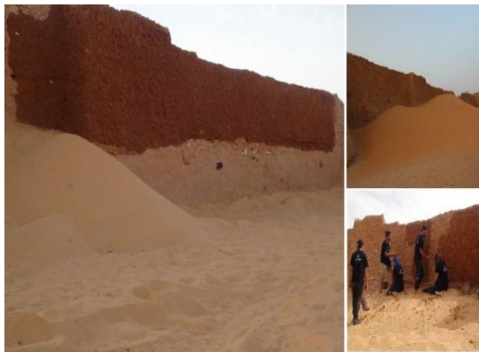
(ث): استخدام الرمال المتركمة على الواجهة الشمالية كسفالة طبيعية
