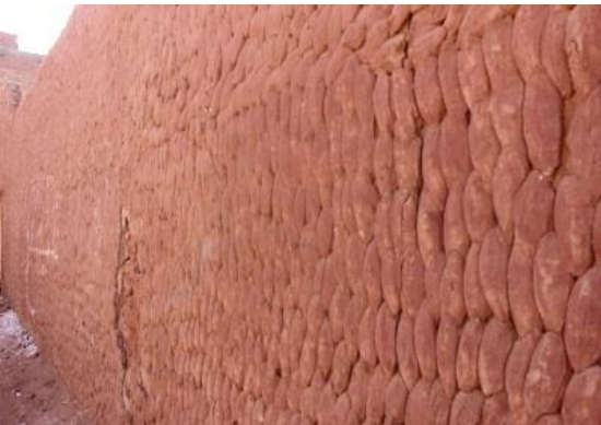
(ح): تلبيس خارجي للجدران بإستعمال مجرفة البناء اليدوية، منزل بتامصلوحت (سيدي بوغراة) بقصر تيميمون
