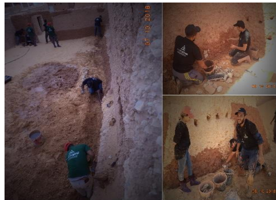
(ت): تعزيز وتدعيم الأساسات بالحجارة
