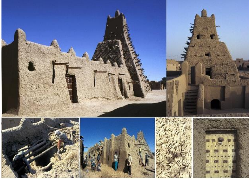
(ر): جامع سنكوري (Sankoré) بتمبكتو مالي؛ الواجهات الصماء، مطرق الباب (النخ)، صيانة وإعادة التسقيف مع التليبس بأصابع اليد، صعودا على السقالات الدائمة في إطار العمل التشاركي، المصدر (Thierry et al., 2012)
