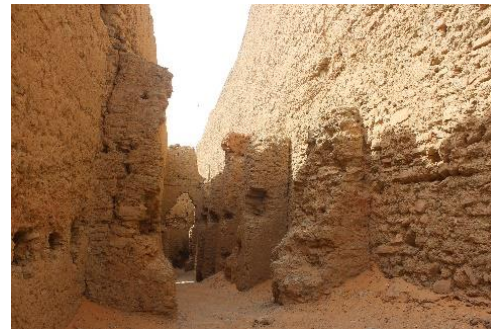
(ت): دعامات إنشائية لتدعيم منتصف الأسوار المرتفعة بأغام تيني كالي، أولاد سعيد
