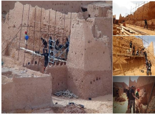
(ح): تصليح وبناء الأجزاء المتضررة للأسوار والأبراج ثم تليسيها
