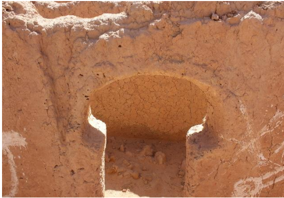
(ب): الشروخات الدقيقة لطبقات الملاط بسبب التمدد والإنكماش بفعل درجات الحرارة، قُصبة الشيخ بوحص تالة أوفروت
