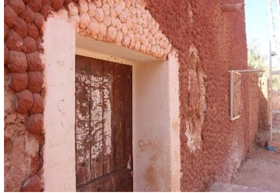
(ت): تلبيس خارجي للجدران بطريقة الكرات اليدوية، دار الجماعة بمغسل بوهدى بقصر تيميمون
