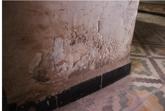
الصورة 54: تأثير ظاهرة التكاثف في تلف مواد البناء الغير عضوية بعمائر إقليم قورارة، مقر المركز (CAPTERRE)، المصدر الباحث
