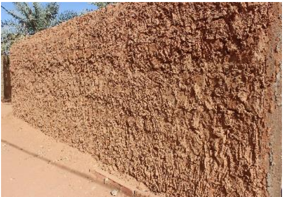
(ج): تلبيس خارجي للجدران بطريقة أصابع اليد، منزل بات المهدي بقصر تيميمون
