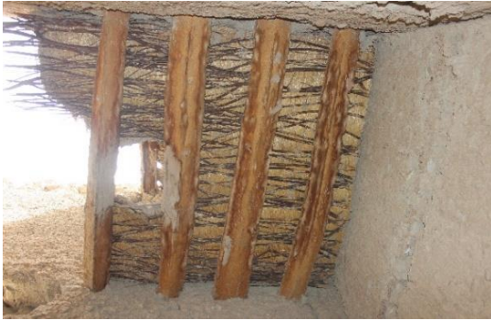
(د): التسقيف بإستعمال جذوع النخيل وأغصان الأشجار (أزوى) بأغمام تيني كالي، أولاد سعيد
