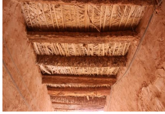
(ت): التسقيف بإستعمال جذوع النخيل ونصول السعف المنزوعة الأشواك، قصر تيميمون
