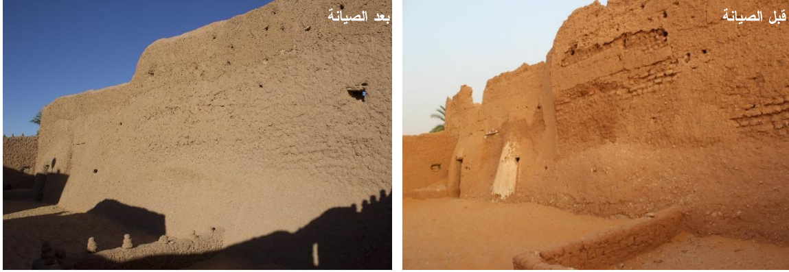
(د): الواجهة المطلة على الجنوب والمدخل الرئيسي للأغام
