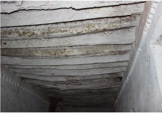
(ح): التسقيف بصف جذوع النخيل، دار الزاوية سيدي أعومر بأوقروت
