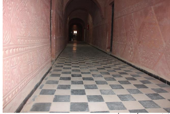
(ت): إحتكاك أسطح الأرضيات بمقر المركز (CAPTERRE) بفعل النشاط اليومي له، الزوار ومستعملي المرفق العام
