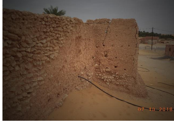
(ت): الحجارة المستعملة ونوعية الملاط الطيني المستخدم
