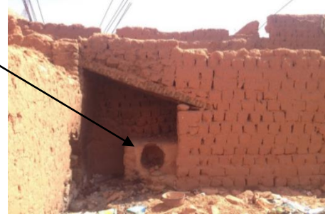
(أ): سلم مبني على سقف مائل من خشب النخيل، منزل بقصر تيميمون
