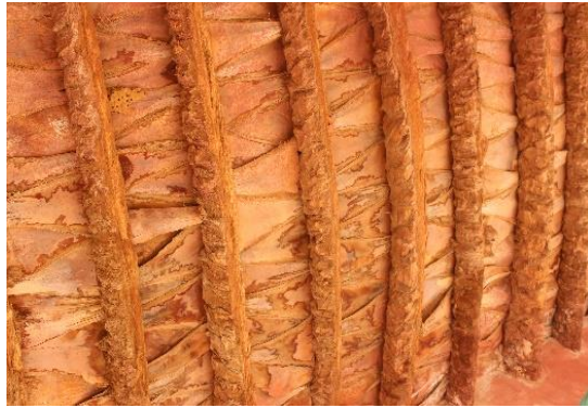
(ج): التسقيف بإستعمال جذوع النخيل والكرناف، مقر المركز الجزائري للتراث الثقافي المبني بالطين بتيميمون
