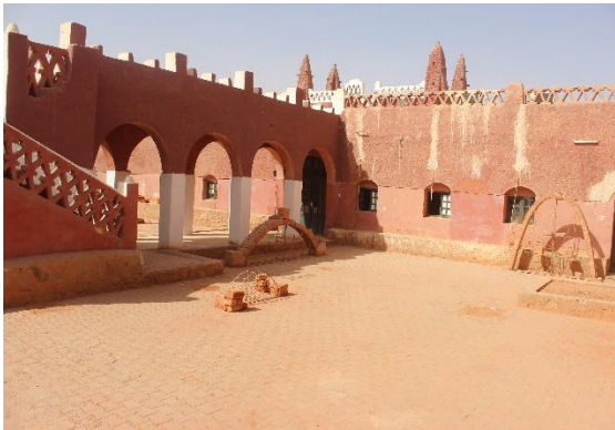
(ب): إستعمال البلاط الإسمنتي المتداخل (Pavés autobloquants) بمقر المركز
