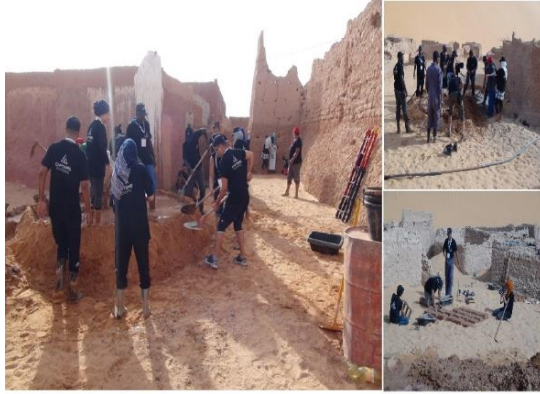
(ب): تلقين إنتاج الطوب الطيني لإعادة بناء الأجزاء المتضررة من أسوار وجدران وأبراج
