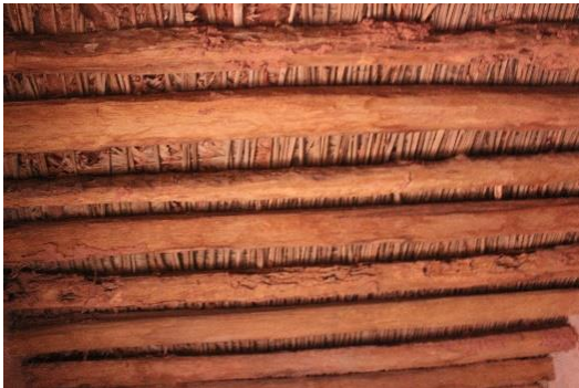
(ب): التسقيف بإستعمال جذوع النخيل وصف الجريد، دار القايد بأولاد عبو دلدول
