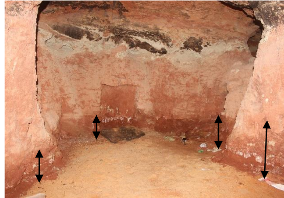
(أ): ارتفاع مستوى منسوب المياه والذي قد يصل إلى (40-60سم)، بإحدى جدران المغارات بقصر بني يسلم شروين
