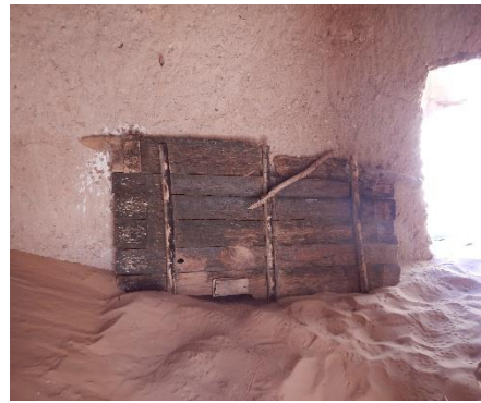
(أ): باب من قطع خشب النخيل مجمعة ومثبة بعوارض، بسيدي منصور قصر قدور تينركوك
