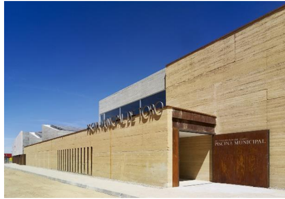
(ت): مسبح بلدي بطورو (Toro) إسبانيا، بتقنية التربة المدكوكة 2010.
