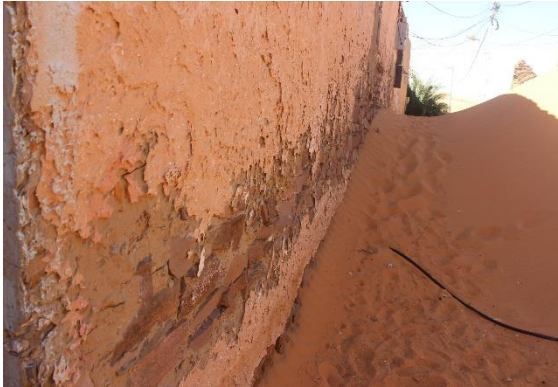
(ث) تآكل الملاط الجيري للجدران بسبب النحت القوي للرياح والمحملة في عمومها بالحصى، قصر أغلاد أولاد سعيد
