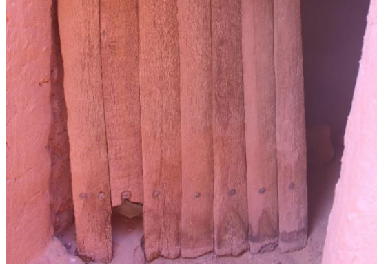
(أ): تأثير الرطوبة/المياه على الجزء السفلي لأحد الأبواب الخشبية (خشب النخيل) تلف عوارضها بتيهديين أغام فاعون، أولاد سعيد
