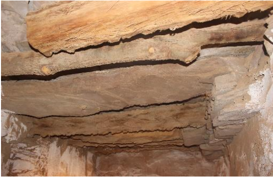
(خ): التسقيف بإستعمال جذوع النخيل والحجارة، بالمصلى الملحق بضريرح سيدي أعمر أغلاد، أولاد سعيد
