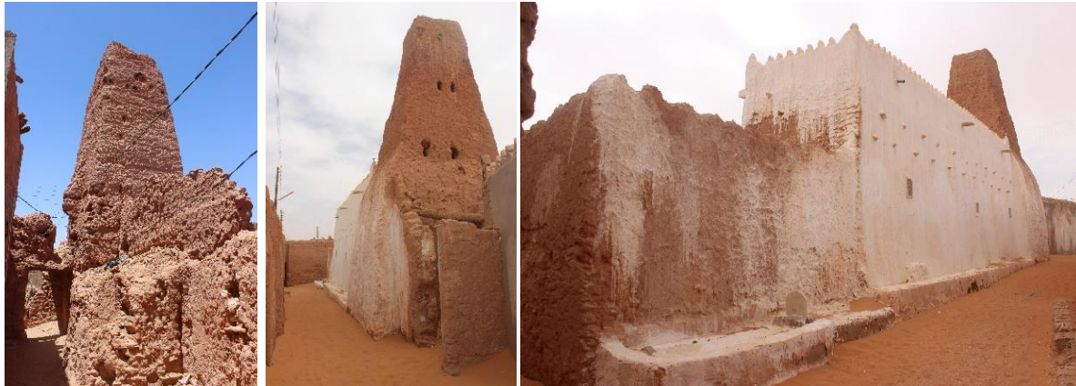
(ز): مئذنة المسجد العتيق والملحقة بروضة الوالي الصالح سيد الحاج عبد السلام الصوفي بقصر بدرين، تيميمون المصدر الباحث (س): مئذنة قصبة أوفران المطارفة أوفروت، المصدر الباحث
