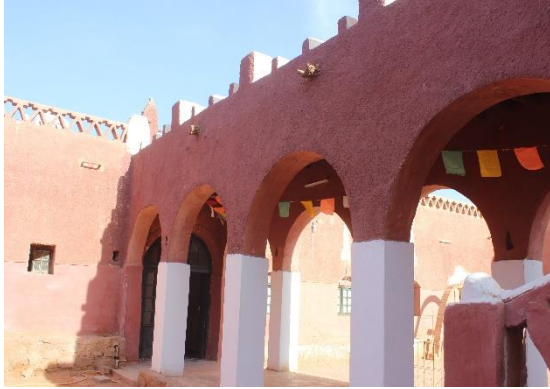
(ث): تلبيس خارجي بالجير لجدران المركز الجزائري للتراث الثقافي المبنى بالطين تيميمون بإستعمال عرجون نخيل التمر
