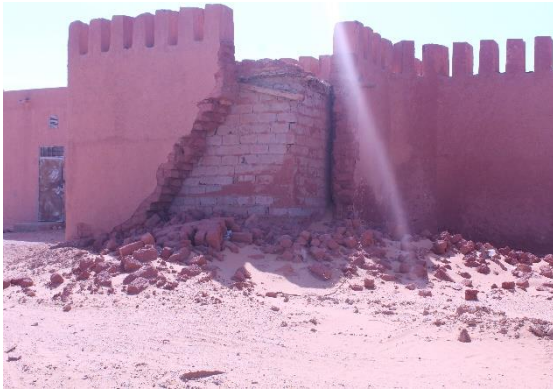
(ح): القرية السينمائية بتينركوك (برج تينركوك-مركز صحاري العالم- سابقا)، التدخل الخاطي؛ بالإستعمال الواسع للإسمنت حين ترميم المعلم سنة 2003
