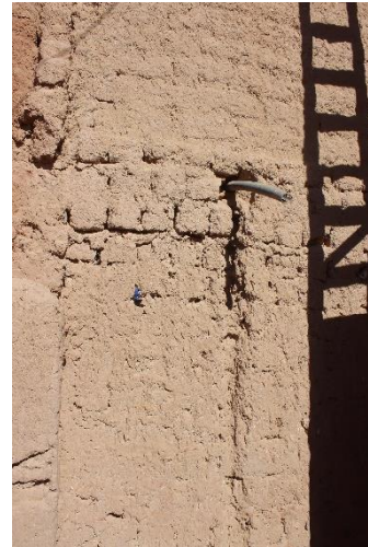
(أ): شروخات بالجدران بفعل تسرب مياه الأمطار عبر الميازيب، إيلحيين كالي، أولاد سعيد
