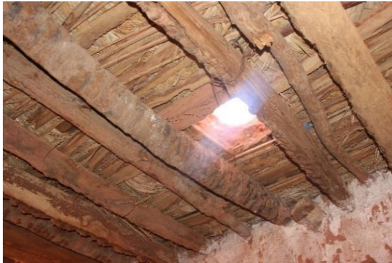
(ب): التسقيف المختلط بإستعمال جذوع النخيل والأشجار (تبركت)
