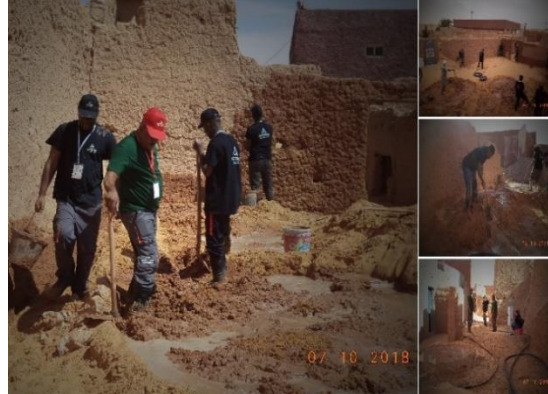
(أ): تحضير خليط الطين وتخمييره لمدة لا تقل عن ثلاثة أيام أو أكثر، بغرض استعماله بمختلف مراحل الورشة
