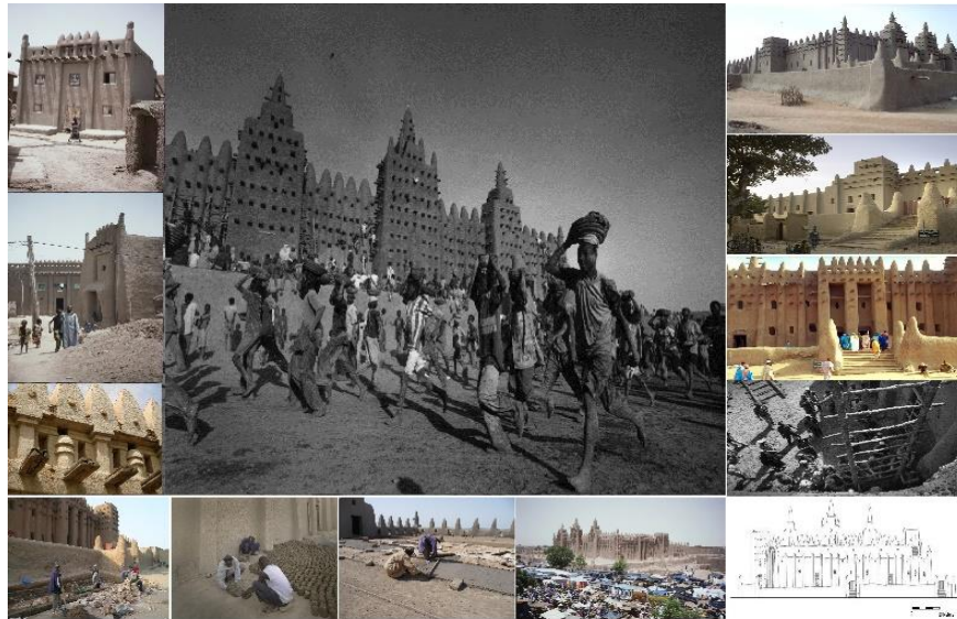
(أ): مدينة وجامع جيني (Djenné) الكبير مالي؛ الواجهات الصماء، الأشكال المثلثة والسقالات الدائمة، صيانة وإعادة التلبيس الجدران بأصابع اليد في إطار العمل التشاركي، المصدر https://www.archnet.org/sites/18886
