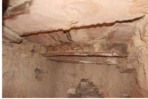
الصورة 39: التسقيف بإستعمال الحجارة بعمائر إقليم قورارة، المصدر الباحث
