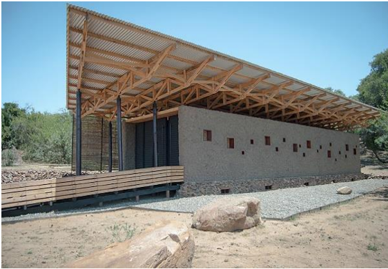
(ح): جناح لإنتاج النبيذ التقليدي بكويلا كوكيناس الشيلي (Quella) بتقنية الإكساء بتربة القش 2012، (Cauquenes chili).
