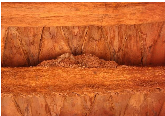
(ب): بناء أعشاش الطيور وتراكم فضلاتها بسقف المركز (CAPTERRE)
