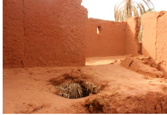
(ت): تساقط جزء من السقف بعد ركود مياه الأمطار به ونفاذها خلاله، دار القايد بأولاد عبو دلدول (ث): تساقط جزء من الملاط الخارجي (التليس) نتيجة التسرب المستمر لمياه الأمطار بين سطح الجدار وطبقة الملاط، قُصبة أورير دلدول
