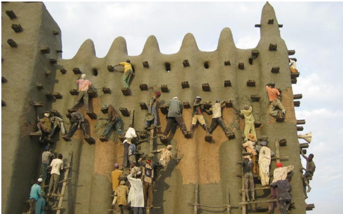
Figure 1.5 : Grande mosquée de Djenné, mali /1906-1907 [13]
