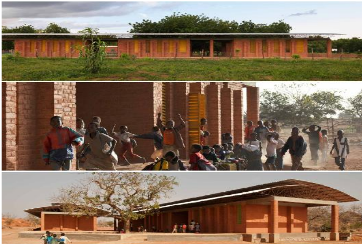
Figure 1.9: L'extension d'une école, Gando, Burkina Faso, Kéré architecture, 2008 [13]
