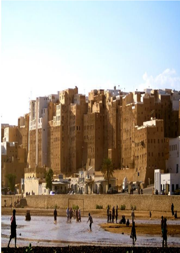
Figure 1.7 : Shibām, Yémen, époque préislamique [14]
