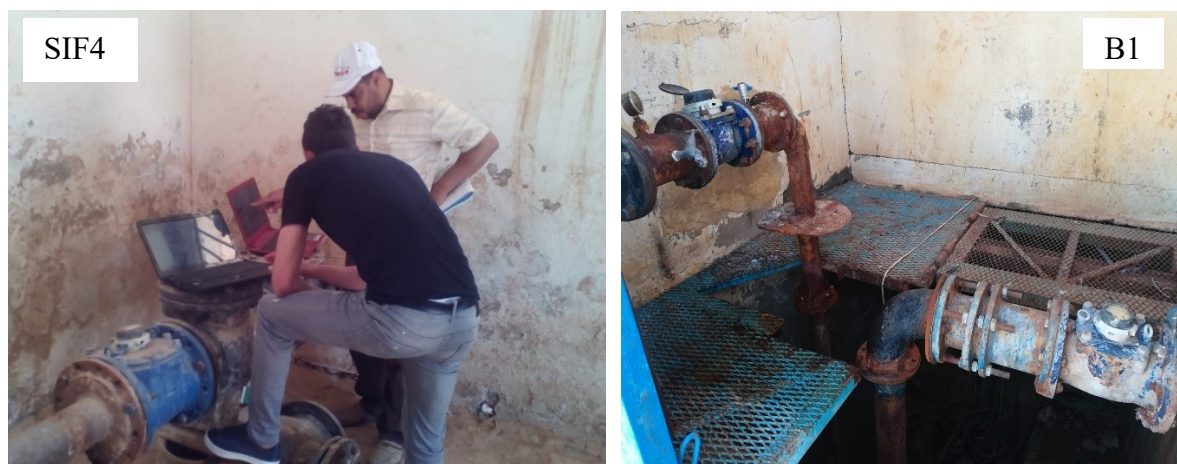
Figure V.9 : Mise en place des Diver
